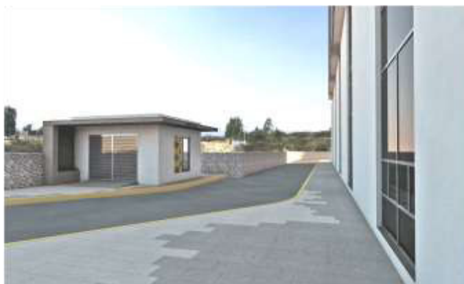
Vista Fachada lateral y vialidad acceso
