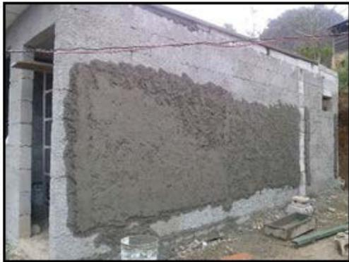
*Ilustración 35. Repellado de muros exteriores.*
