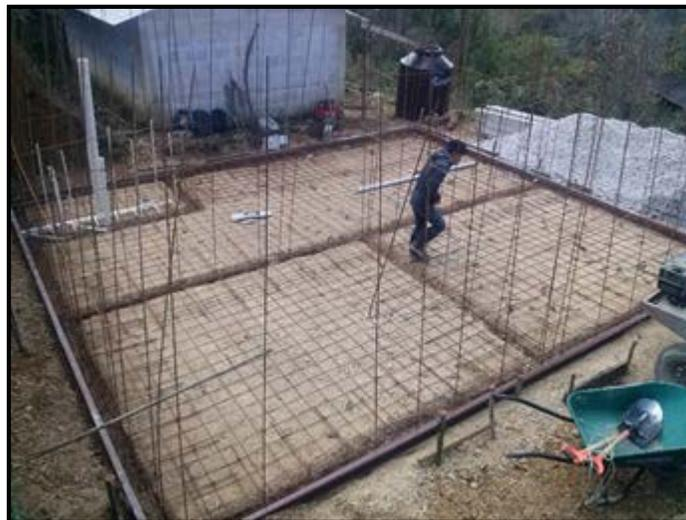
*Ilustración 33. Supervisión del armado de losa.*
