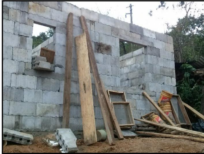
*Ilustración 34. Levantamiento de muros*
