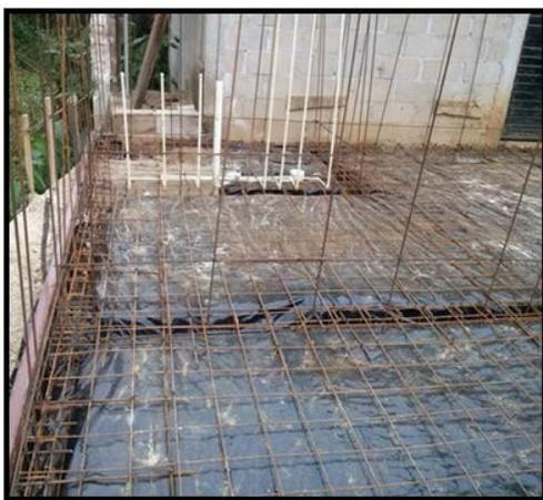
Ilustración 23. Instalaciones Hidráulicas.
