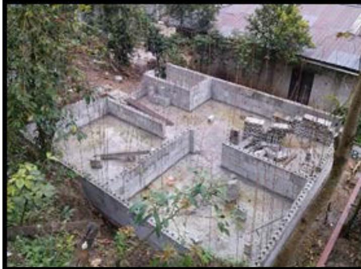
*Ilustración 18. Imagen de desplante de muros.*
