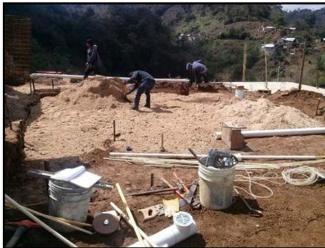
*Ilustración 32. Compactación de terreno y excavación para trabajos de cimentación*
