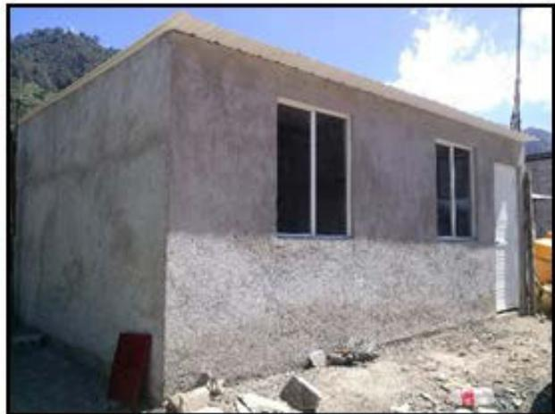
Una vez colocado el repellado, se continuaba con la colocación de la techumbre a base de la lámina ULTRALAM, la cual se soportaba a través de montenes colocados en el sentido largo y los cuales eran soldados con las varillas que venían en sentido vertical desde la losa de cimentación, esto para que hubiese agarre entre la techumbre y la estructura de los muros, ya que con esto se lograba el principio básico de la construcción en la arquitectura: Formación de Marcos.
