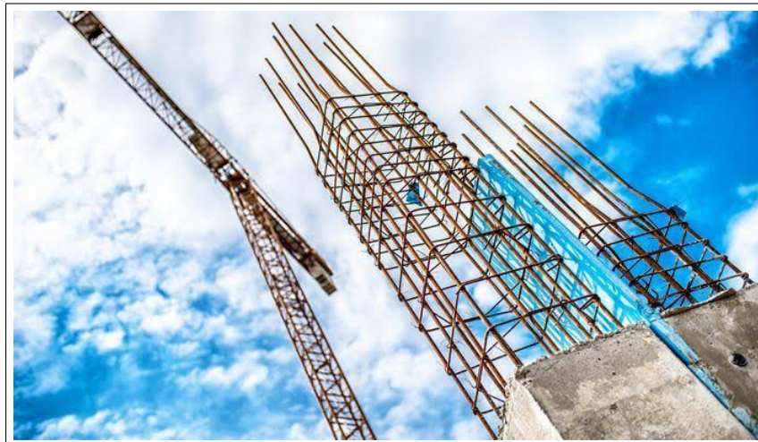
Figura 2.7: Columnas de concreto reforzado (Bogdan.hoda, 2015).
