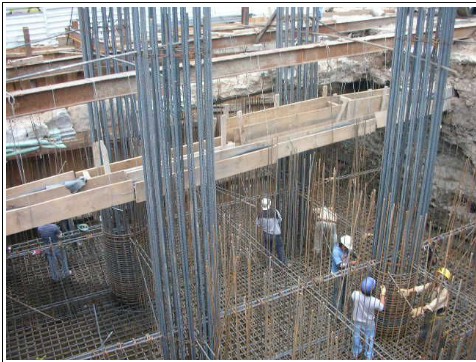
Figura 2.6: Acero de refuerzo (García, s. f.).
