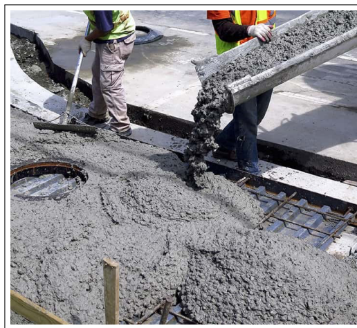
Figura 2.1: El concreto es un material con gran trabajabilidad (ARDA, 2018).
