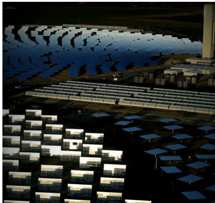
Figura 3.2 Planta de energía termosolar de Abengoa en Sanlúcar la Mayor. Fuente: (Periódico El País, 2015).
