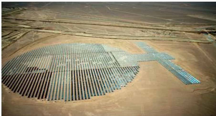
Figura 3.4 Proyecto ESCO de la mina de cobre Gaby. Fuente: (Appsol, 2021).
