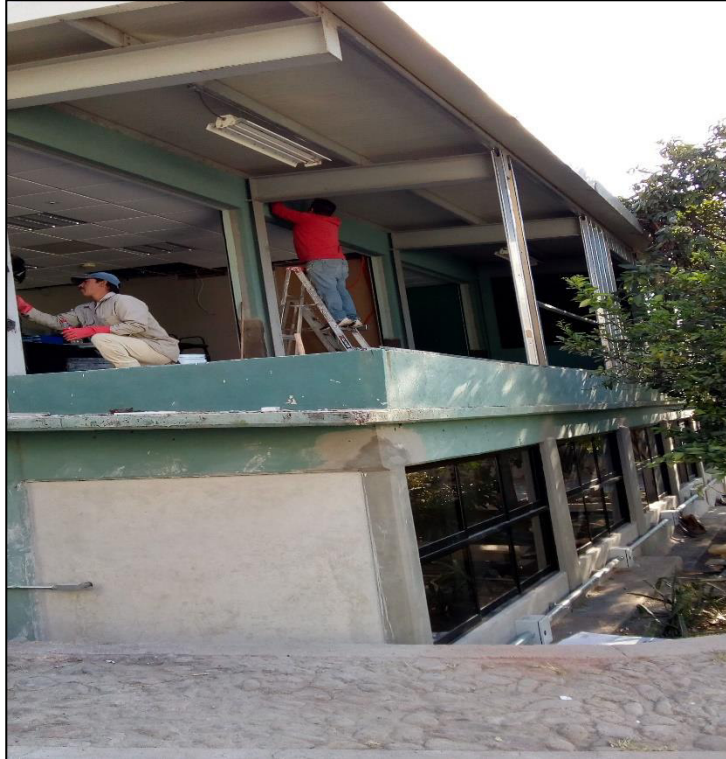
Figura 6 - Obra civil en edificio Infraestructura Noria Alta
