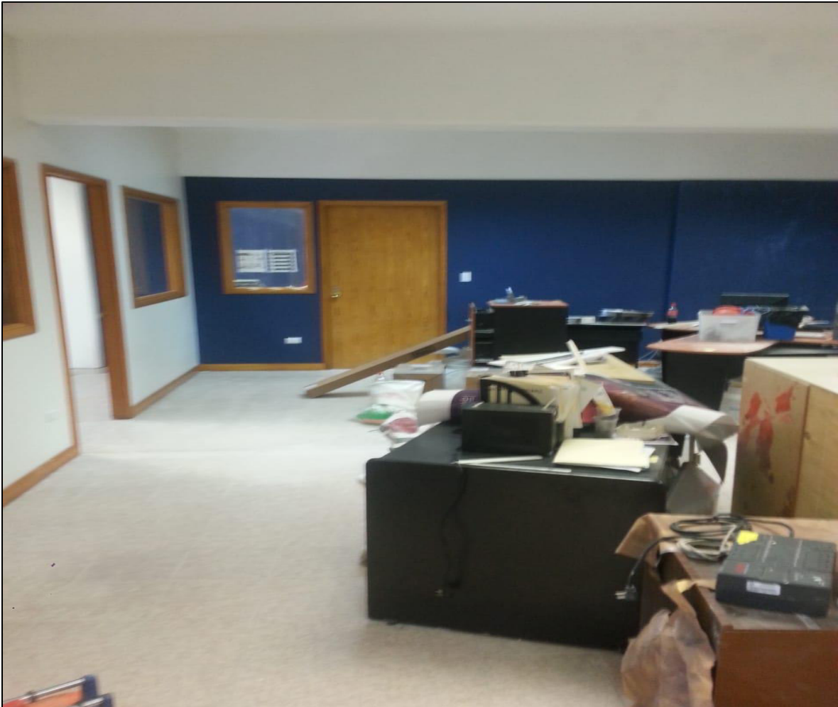
Figura 9 - Termino de obra civil planta baja Noria Alta 8 de enero 2018
