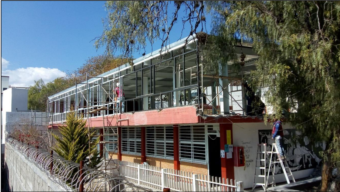
Figura 14 - Trabajos de obra civil en los cubículos de tutorías febrero 13 de 2018
