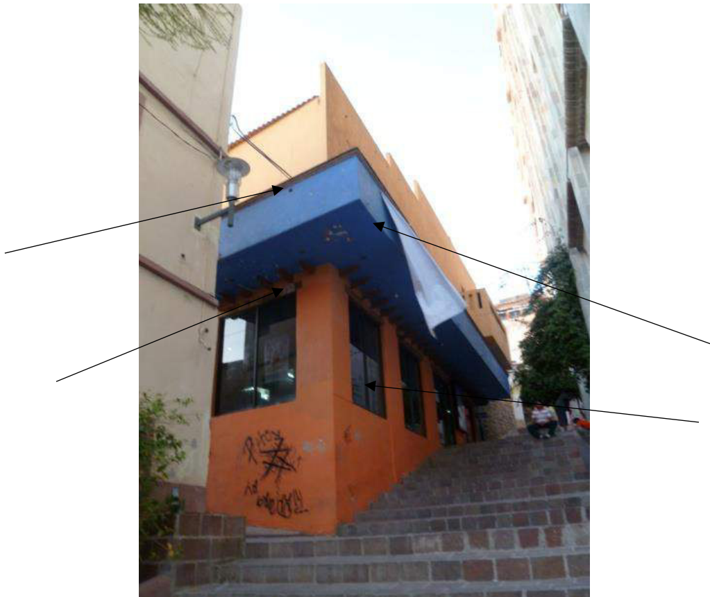
Ilustración Fachada y sus elementos de pertenencia
