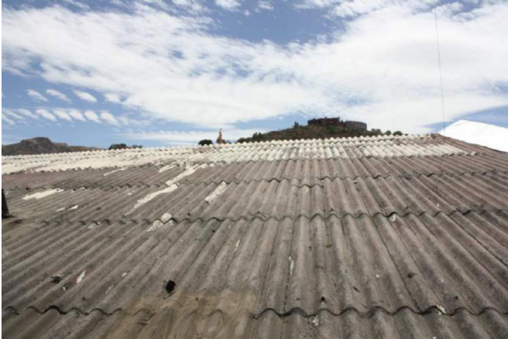
Ilustración 1 Súper estructura del edificio
