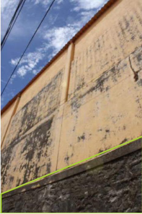
Ilustración Cimentación del edificio desde callejón lateral
