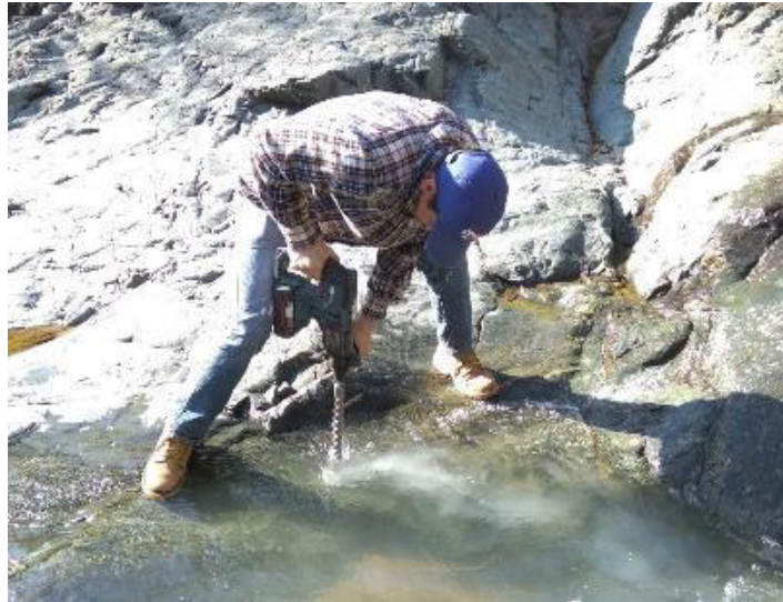
Figura 8. Trabajo de perforación del cauce Sirio 2.
