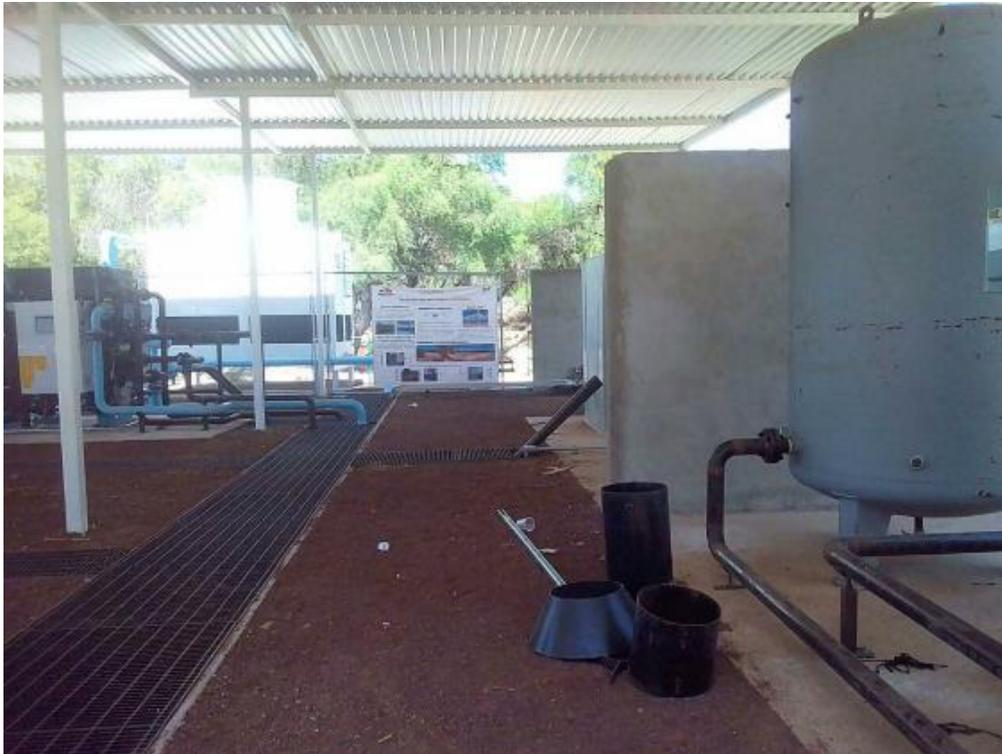
**Maquina Enfriadora por Absorción Libr-H2O (Chiller) Marca Thermax (Equipo de la Parte Superior Izquierda)**
