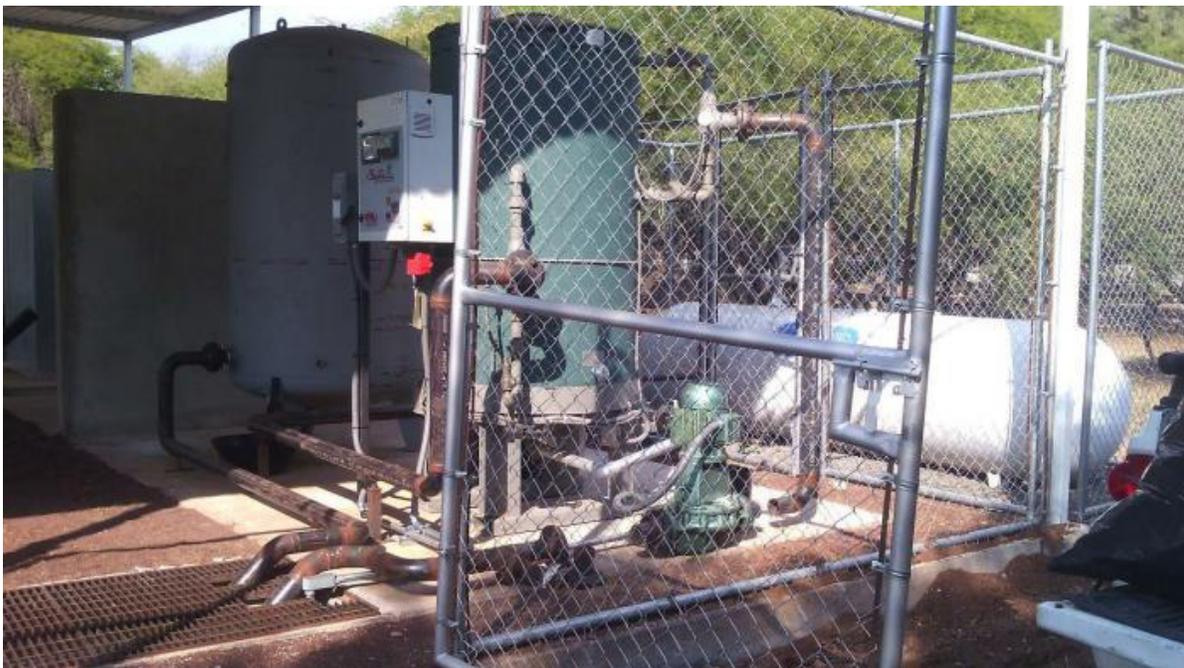
**Circuito de Agua Caliente, Caldera, Tanque de Almacenamiento de Agua Caliente, Tanque de Gas L.P. e Intercambiador de Calor**
