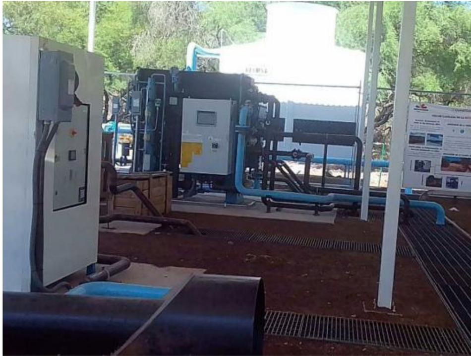
**Conexión de Agua de Enfriamiento para la Máquina Enfriadora por Absorción (Tubería Azul)**
