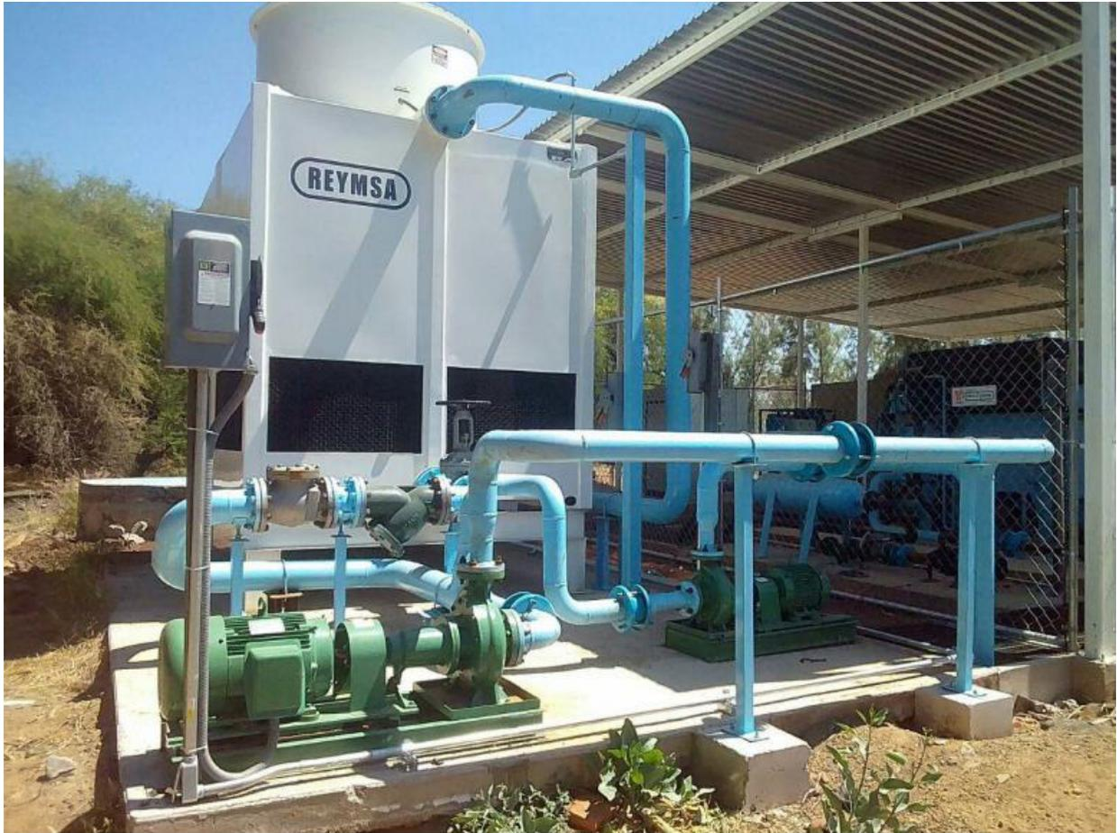
**Cabezal de Bombas de Alimentación de Agua de Refrigeración**
