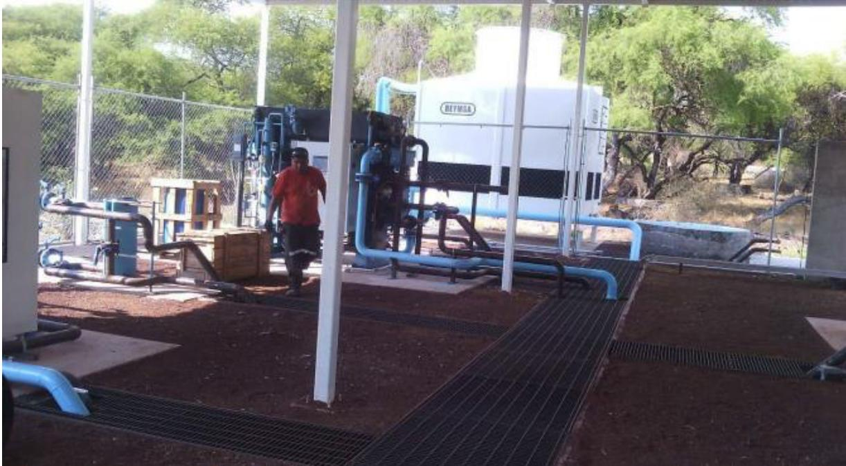
**Circuito de Alimentación de Agua Helada (Chiller, Intercambiador de Calor y Cámara Frigorífica)**
