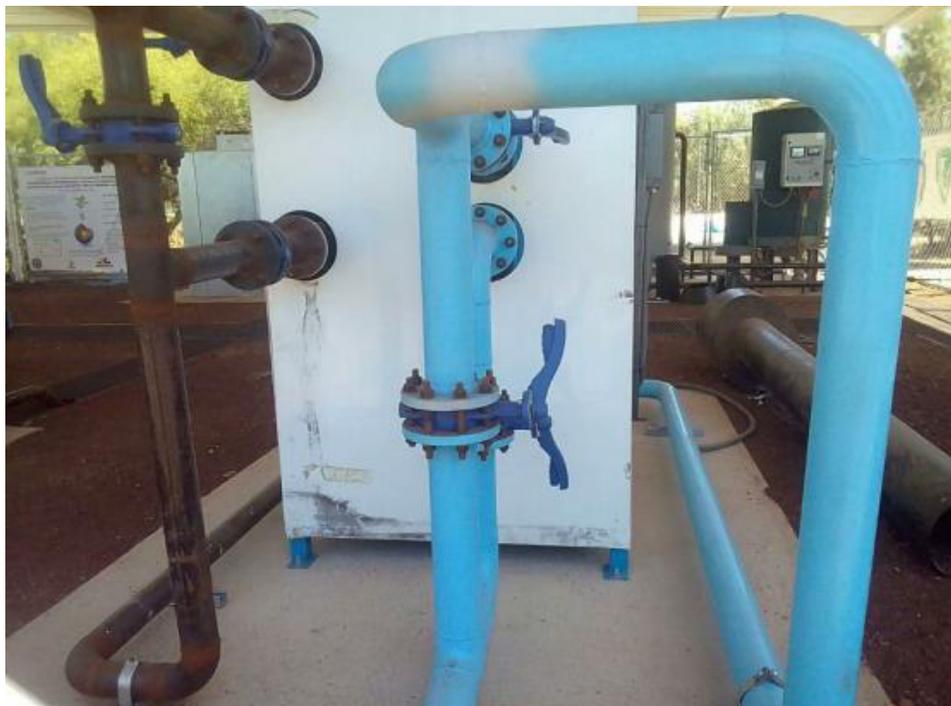
**Conexión de Agua de Enfriamiento para el Orc (Tubería Azul)**
