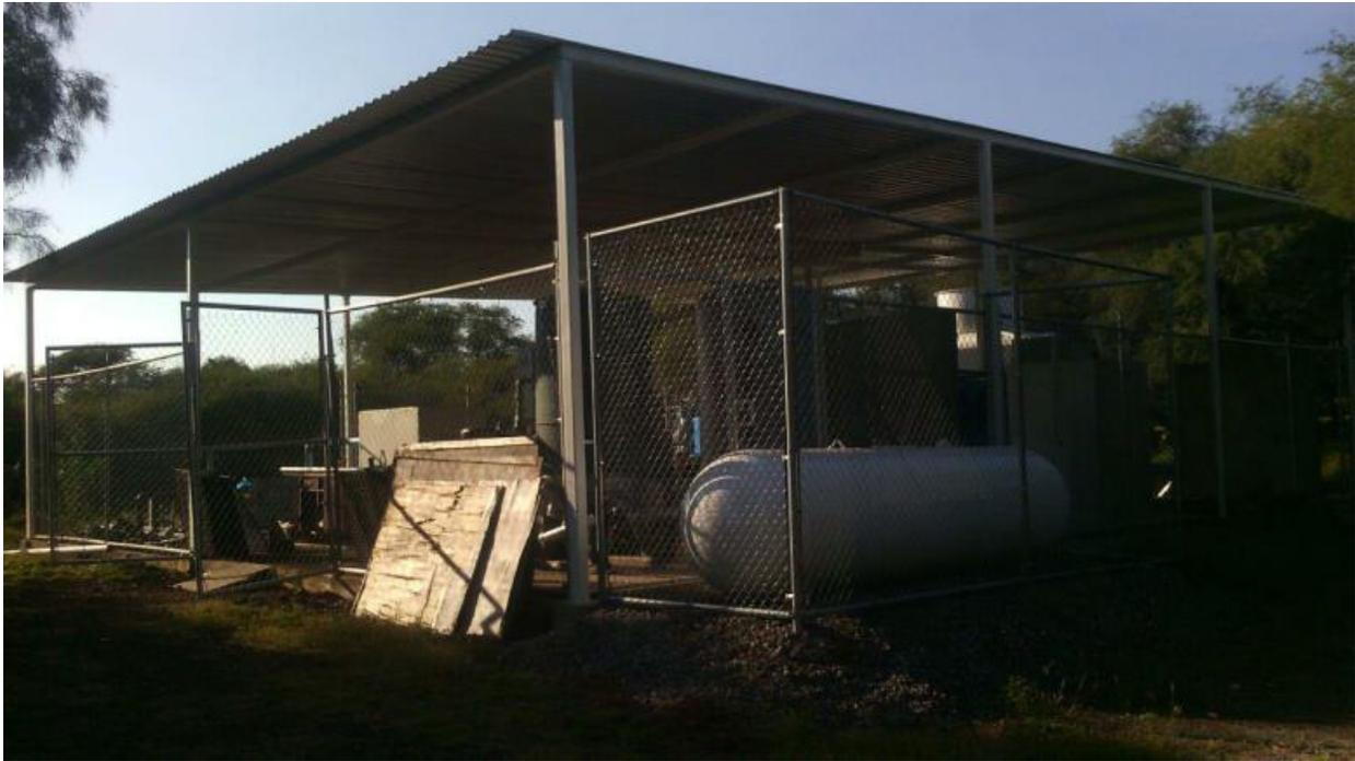
**Estructura a base de ptr de 4 x 4 plg, monten de 4 x 2 plg y malla ciclonica de 2.5 m de altura**
