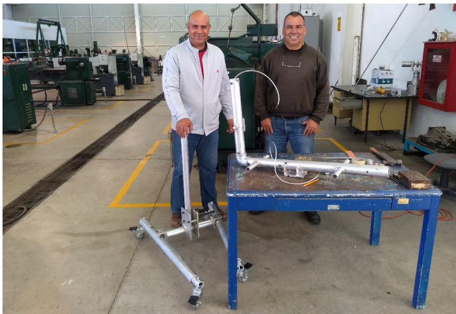
Imagen 119. Proceso de construcción de la grúa
