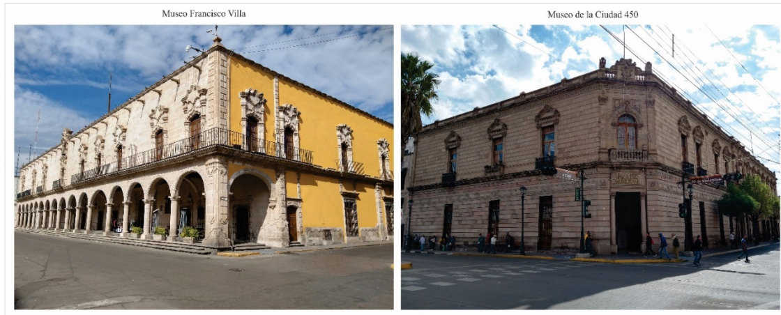
Figura 6. Ejemplo de inmuebles donde se prioriza su valor de consumo. Fuente: Fotografías tomadas por A. Reyes.
