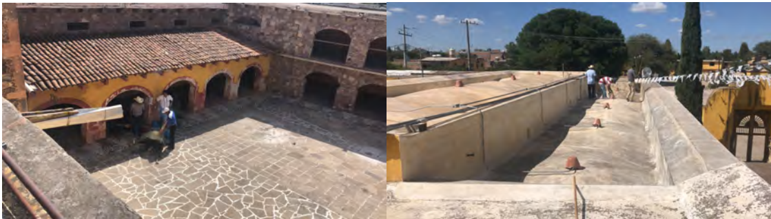
Preparación del jabón y alumbre para la impermeabilización e impermeabilización de la boveda en la capilla de la Letania.
