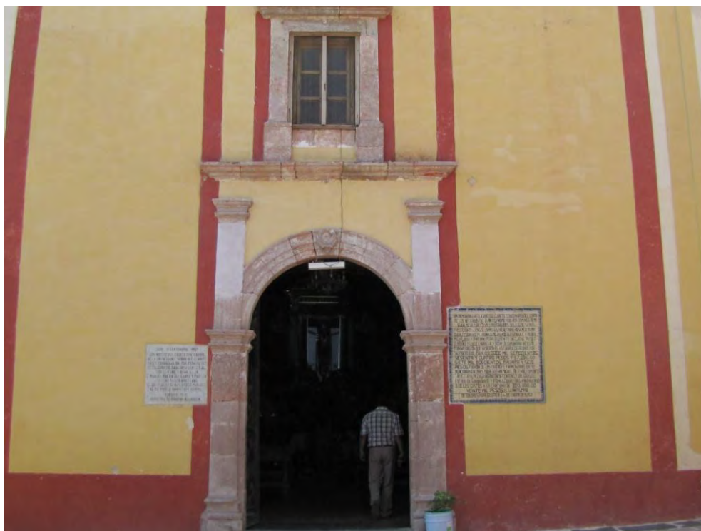
Placa que asienta o testimonia la antigüedad u origen de la edificación del templo y asentamiento humano de la comunidad
