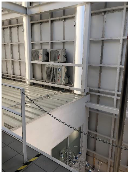
Ilustración 6. Estructura de acero. Estación de bomberos. Fuente: propia.
