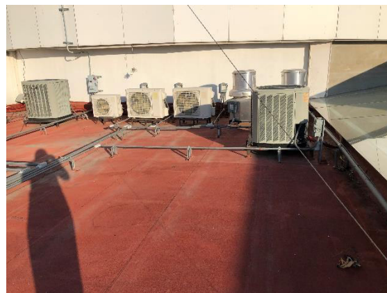
Ilustración 13. Uso de extractores en estación de bomberos. Fuente: propia.
