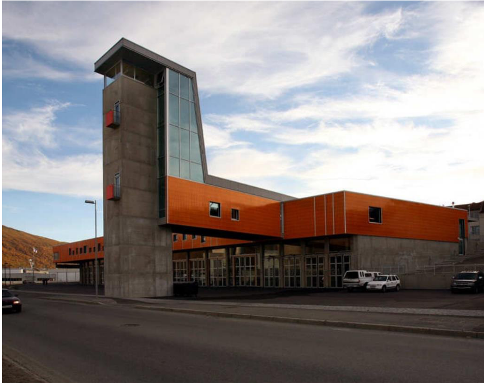
Ilustración 16. Torre de Estación de bomberos Tromsø. Archdaily
