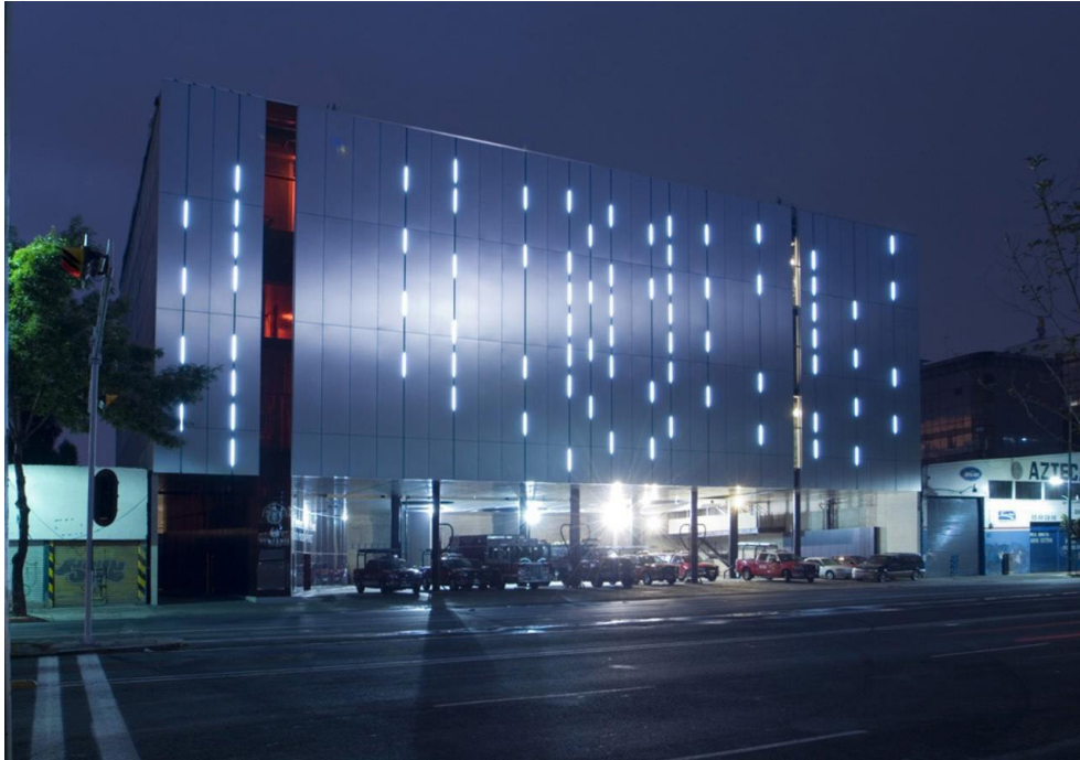
Ilustración 21. Vista frontal de Estación de bomberos Ave Fénix. Archdaily
