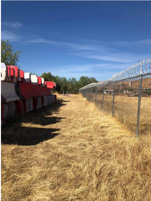
Ilustración 96. B6-Vista hacia el Oeste desde el interior. Fuente: propia.
