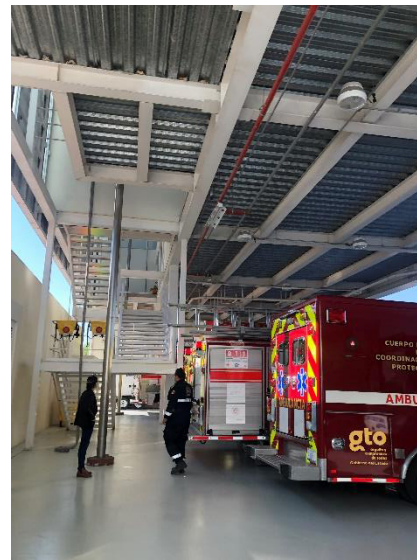
Ilustración 7. Losacero. Estación de bomberos. Fuente: propia.
