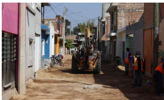
Imagen 1. Trabajos de pavimentación de calle.
