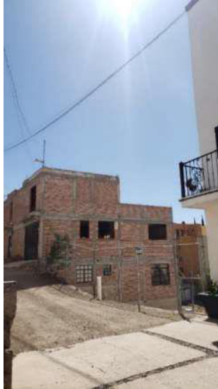
Fig. 28: Vista de Calle a terreno, Aproximación a terreno, Fuente: Propia.
