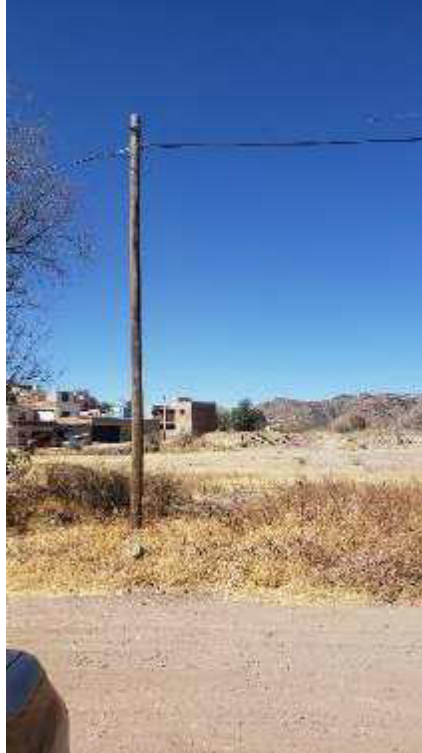
Fig. 41: Poste de teléfono frente a predio, parte baja. Fuente: Propia.
