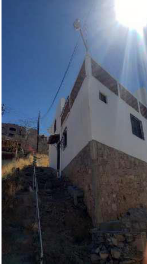
Fig. 37: Continuación del cableado de la casa contigua al predio. Fuente: Propia.
