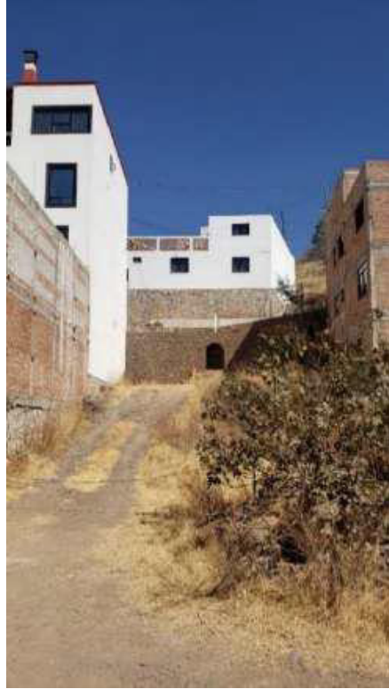
Fig. 29: Vista de calle a terreno, aproximación a terreno. Fuente: propia.
