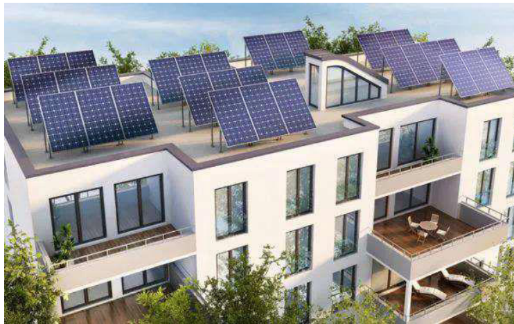
Fig. 03: Imagen representativa de paneles solares.
