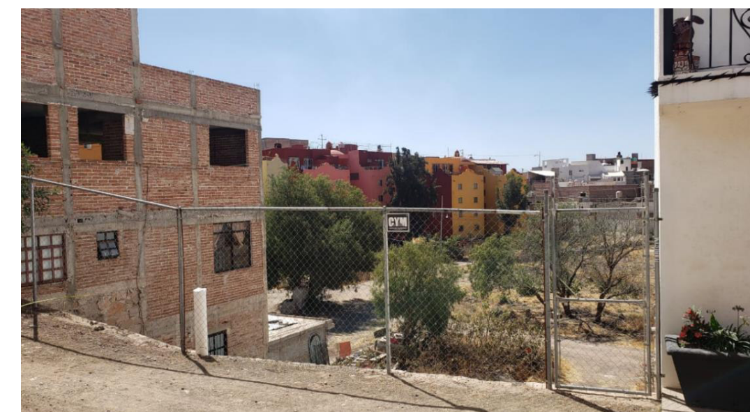
Imagen 3, Vista desde Calle a terreno, Vista a Sureste.
