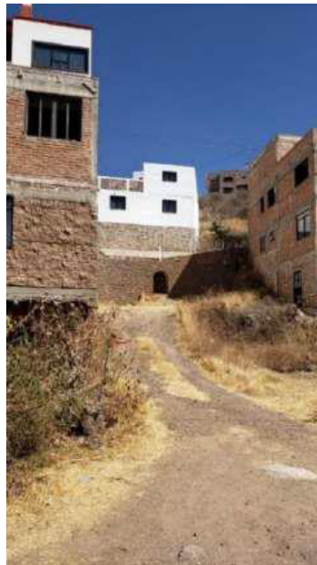
Fig. 30: Vista de calle a terreno, vista al Noroeste, se ve la calle de arriba. Fuente: Propia.
