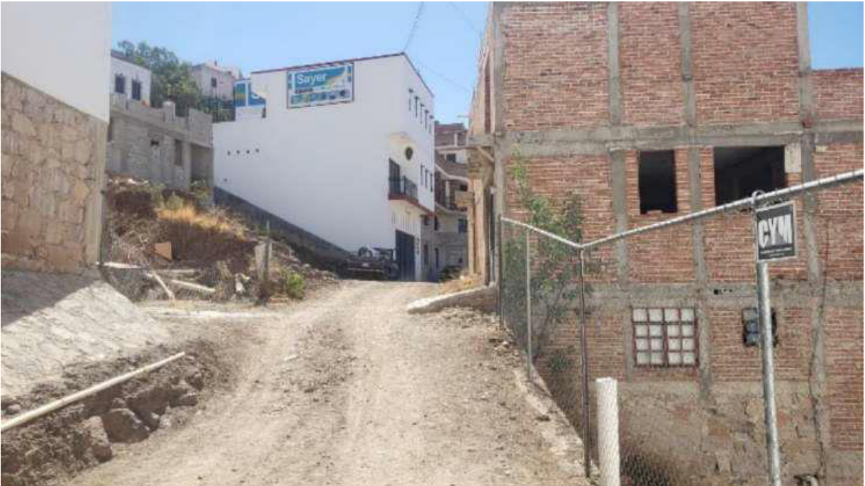
Fig. 34: Tubo PVC de la zona Fuente: Propia.
