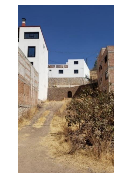
Imagen 6, Vista de Calle a Terreno Vista a Noroeste.
