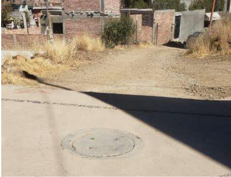
Fig. 42: Vista de pozos de Visita de la zona. Fuente: Propia.
