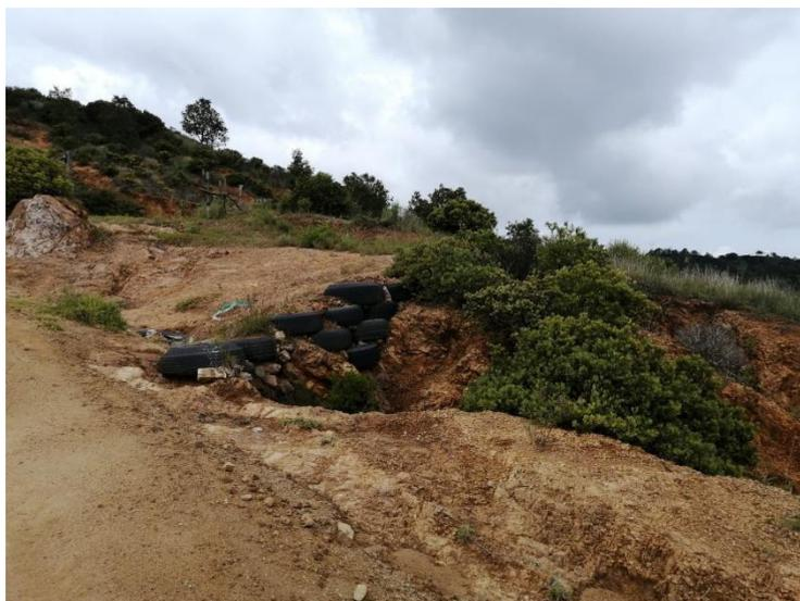
**Figura 13.** Pequeñas represas construidas con neumáticos para disminuir la velocidad de escorrentía y mitigar la erosión hídrica en la microcuenca “El Laurel”. Autoría propia (2021).
