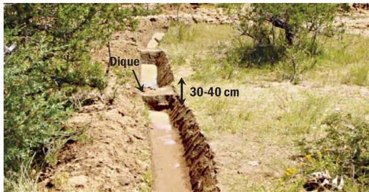
**Figura 72.** Zanja bordo con diques cada 4 metros y a la altura del suelo. Recuperado de Cardoza et al. (2006).
