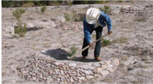
**Figura 70.** Terraza individual con taludes estabilizados. Recuperado de CONAFOR (2007).
