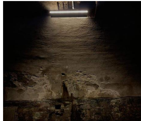
Figura 7. Muro con salitre, zona Alonso. Tomada en 2021.
