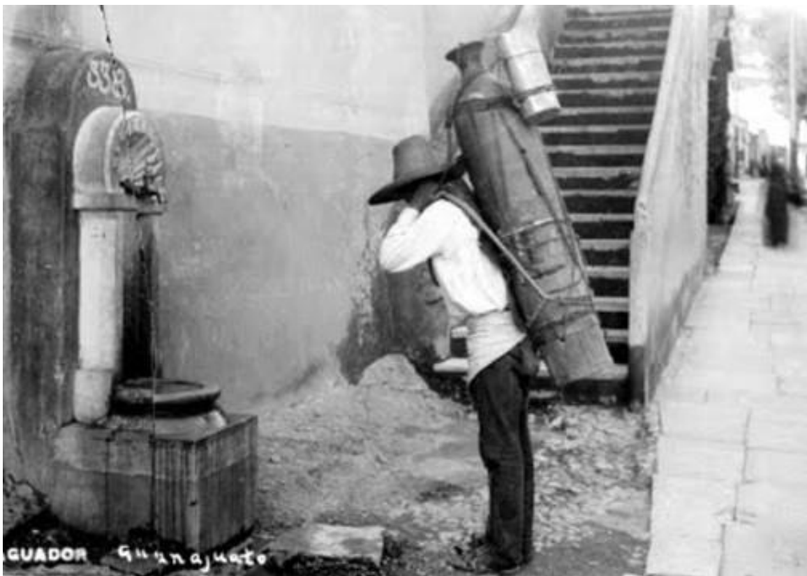
IMAGEN 5. HIDRANTE Y AGUADOR
