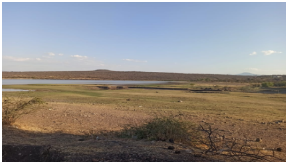
Presa de Barajas
