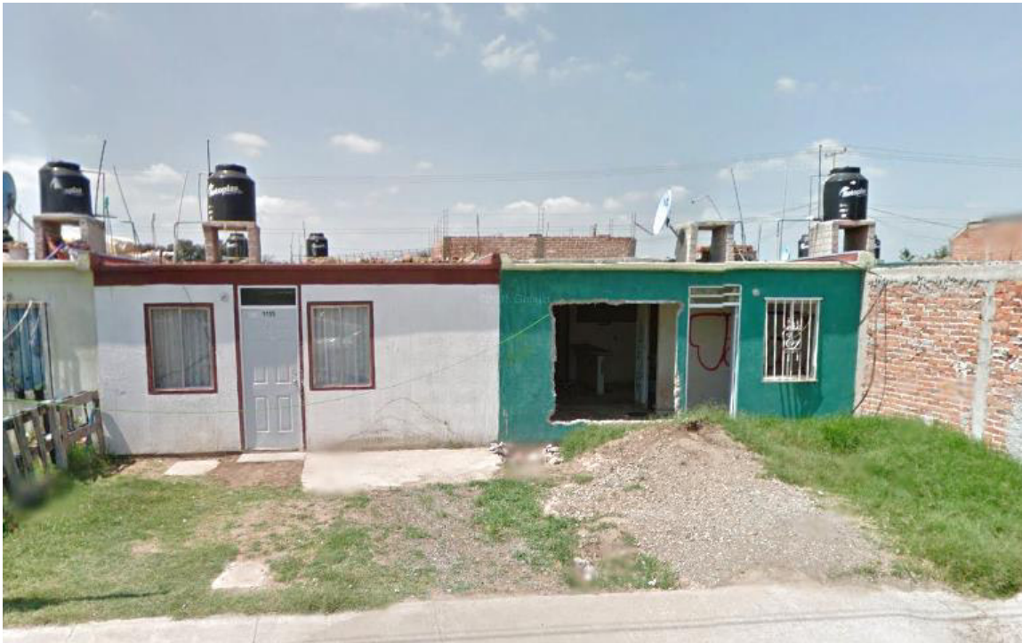
Ilustración 5 Viviendas abandonas en Fraccionamiento "Las Liebres" en Irapuato
