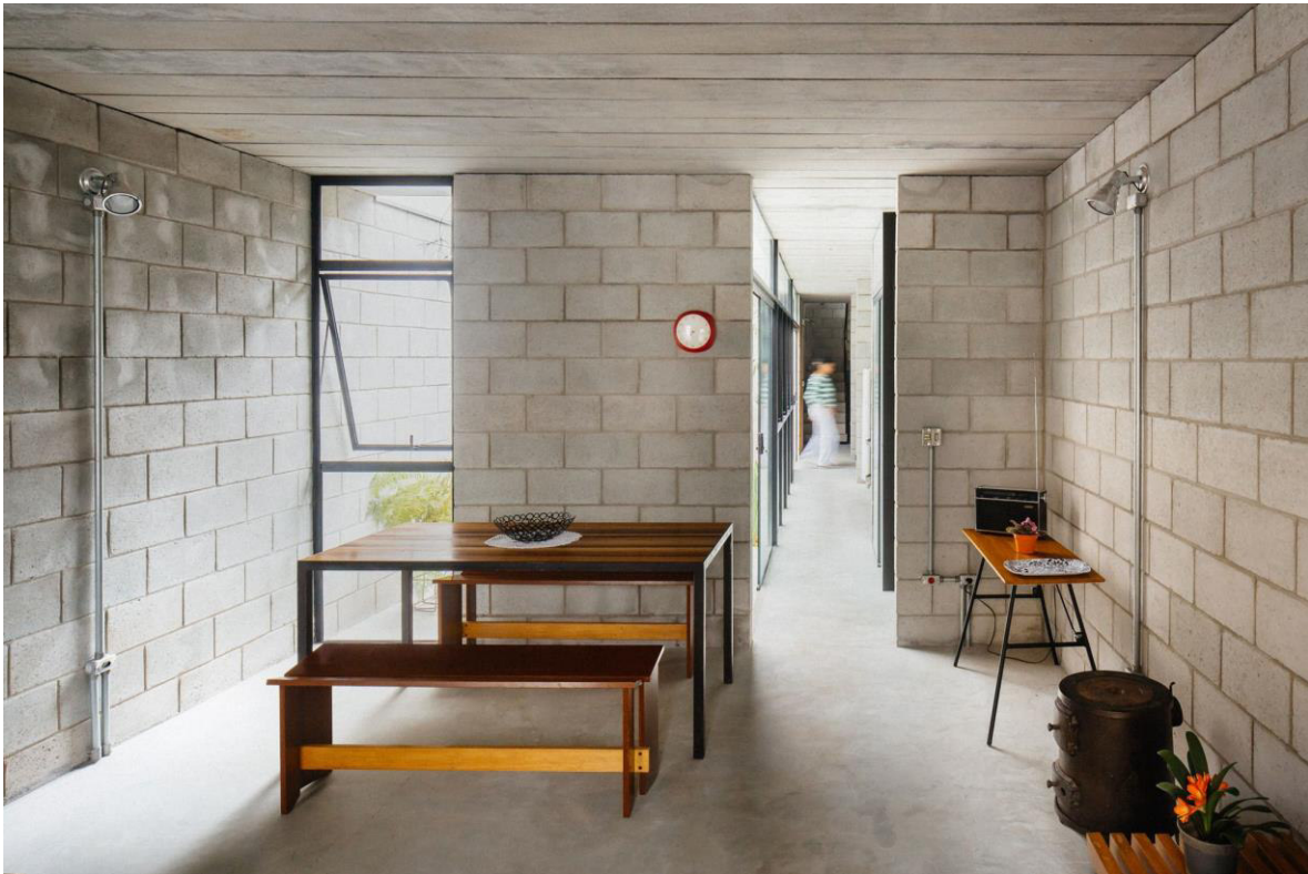
Ilustración 19 Vivienda de mampostería de block hueco
