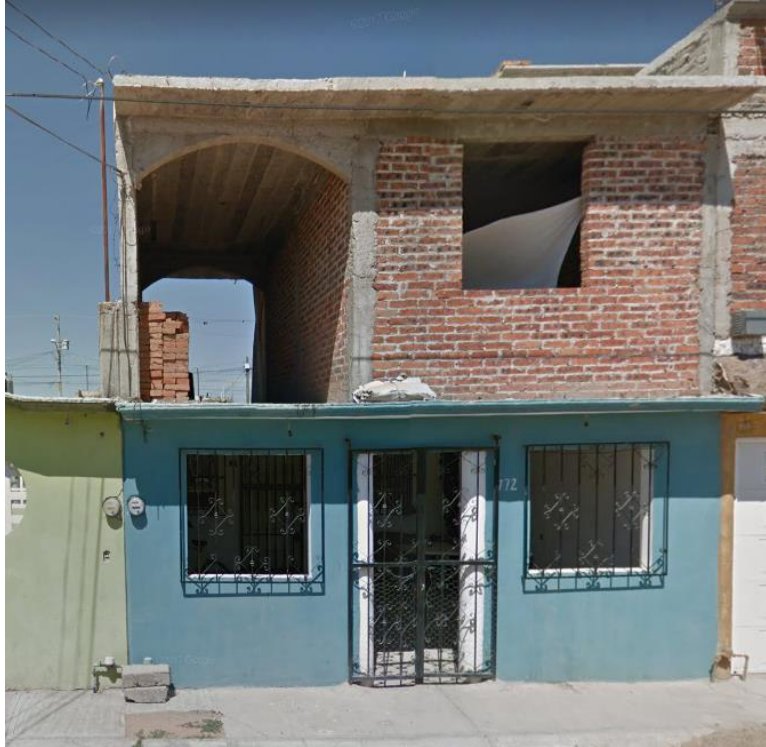
Ilustración 14 Casa con la parte de arriba en obra gris
