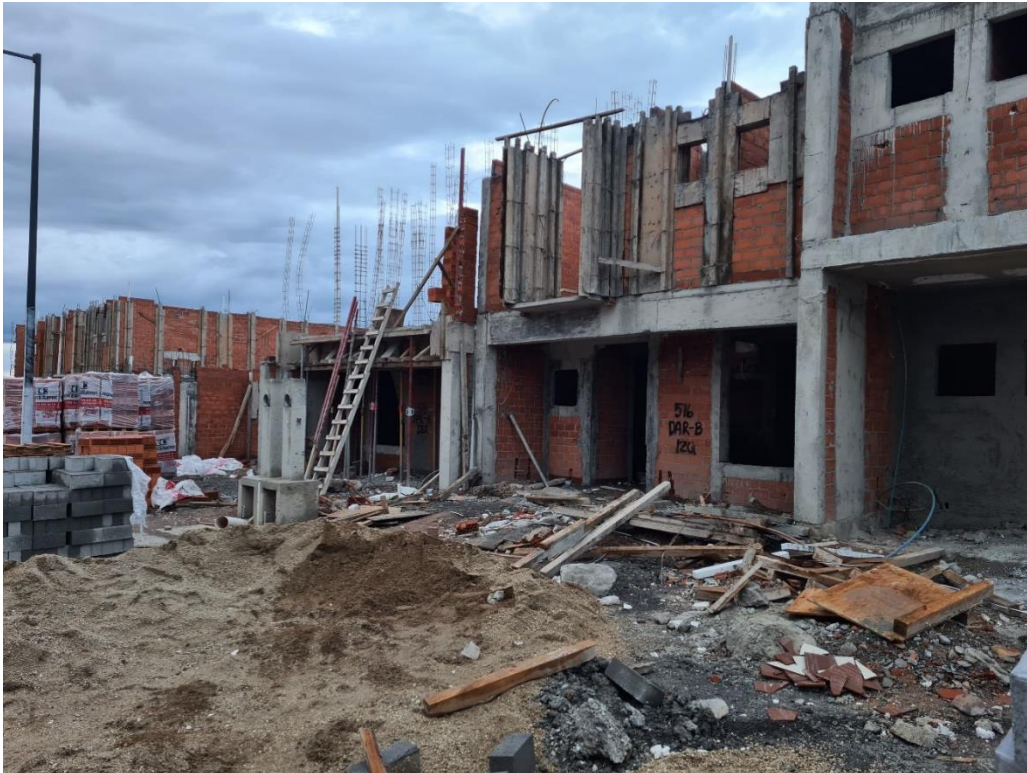
Ilustración 18 Vivienda de mampostería de ladrillo
