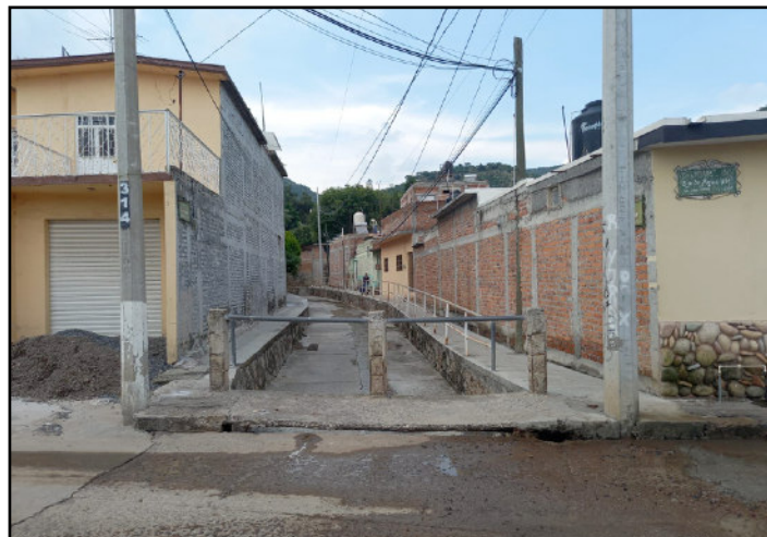
Ilustración 34. Puente en calle Ojo de Agua. Fuente: Elaboración propia.
