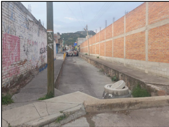
Ilustración 37. Puente en calle Galeana. Fuente: Elaboración propia.
