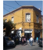
IMAGEN 2: Fachada con esquina en pancoupé, ventanas y puertas con marco de cantera, ritmo y continuidad en vanos. FUENTE: Lucero
