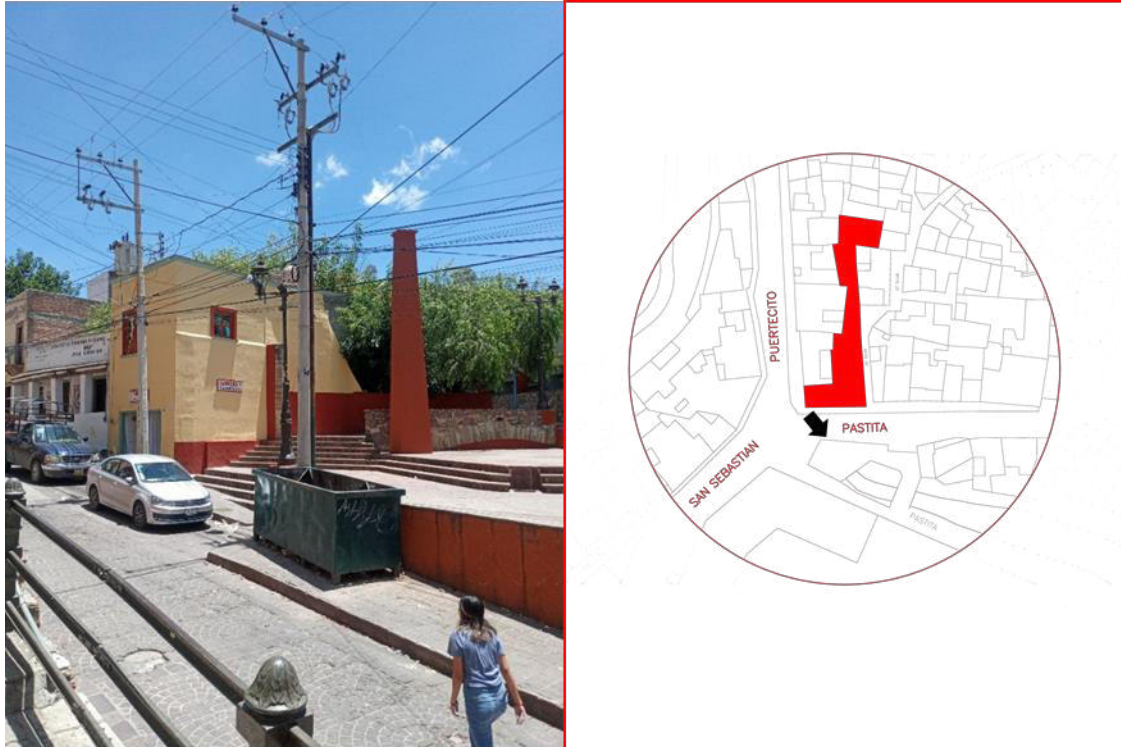
IMAGEN 13. CONTAMINANTES EN CALLE DE PASTITA, INFRAESTRUCTURA, 2021.
