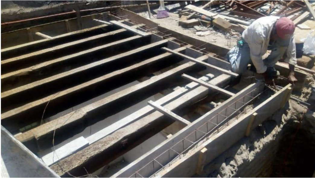
IMAGEN 20. RESTAURACIÓN DE TECHO EN RECÁMARA 1, INTERVENCIONES ANTERIORES, 2018.
