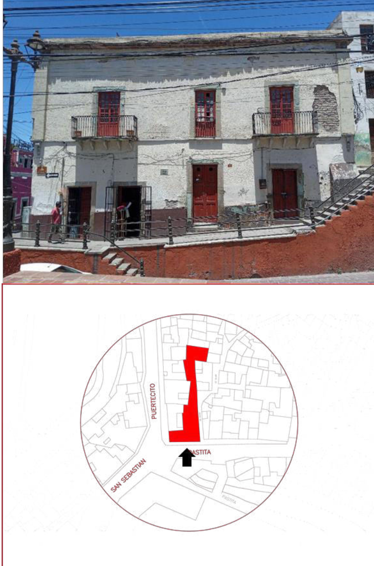
IMAGEN 18. FACHADA SUR, ANALISIS DEL INMUEBLE EN SU ESTADO ACTUAL, 2021.
