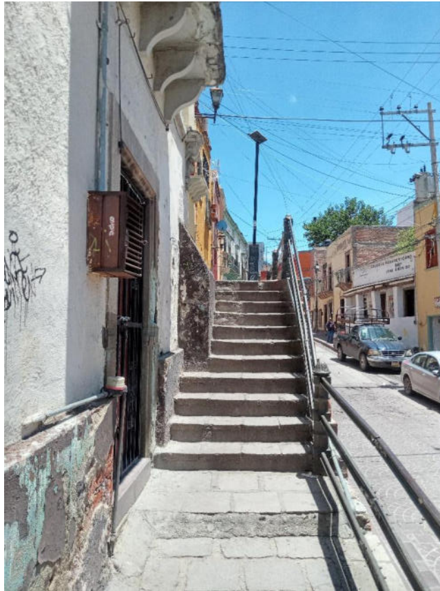
IMAGEN 32. BANQUETA EN FACHADA SUR CALLE PASTITA, CRITERIOS CONSTRUCTIVOS, 2021
