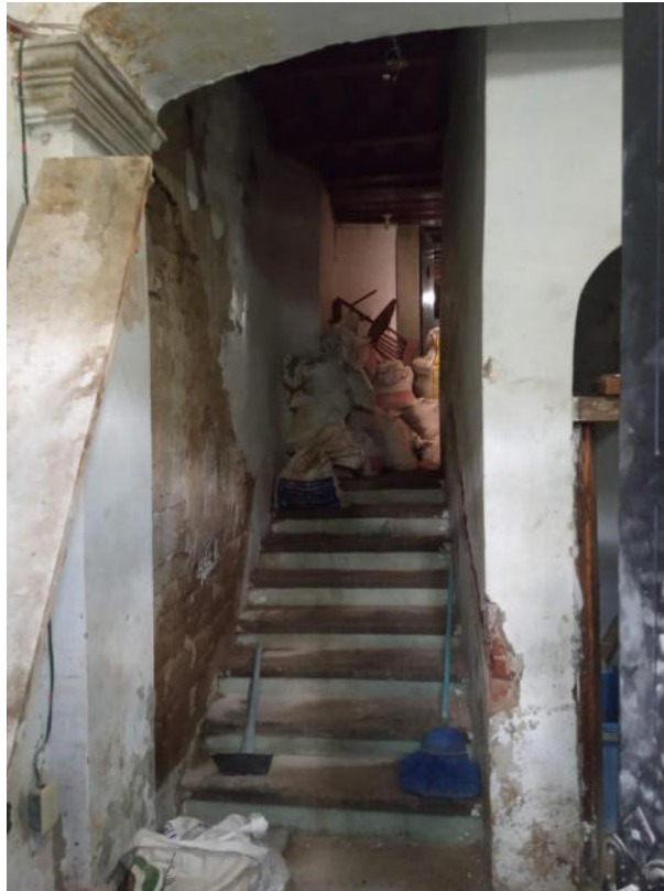
IMAGEN 16. VISTA INTERIOR AL ZAGUÁN, ANALISIS DEL INMUEBLE EN SU ESTADO ACTUAL, 2021.
