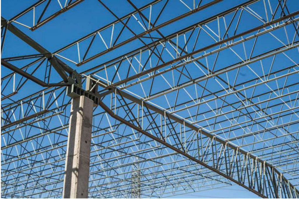
IMAGEN 27. SISTEMA STEEL JOIST , CRITERIOS CONSTRUCTIVOS, 2021
