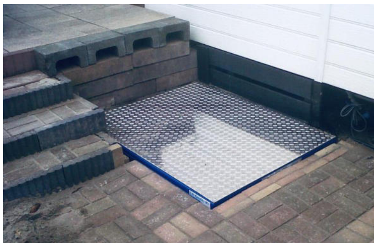
IMAGEN 36. MESA DE ELEVACIÓN ELÉCTRICA TIPO TIJERA EN TIENDA IDENTIDAD UG, CRITERIOS CONSTRUCTIVOS, 2021
