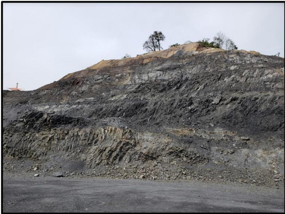
Figura 41. Falla del talud en material de mala calidad
