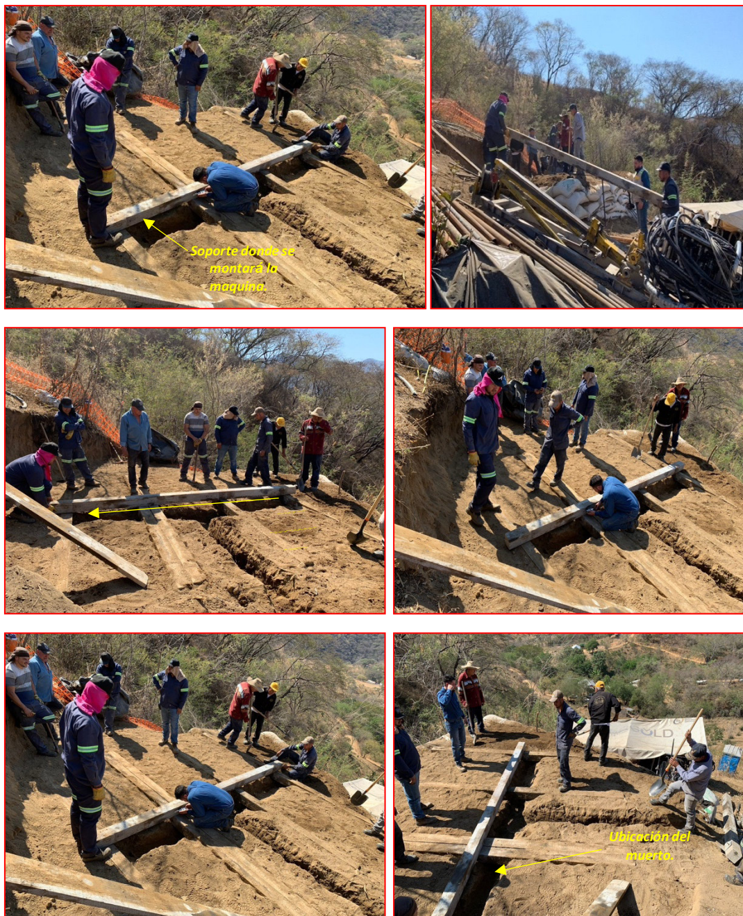
Figura 6. Alineamiento de polines (Parte 2).
