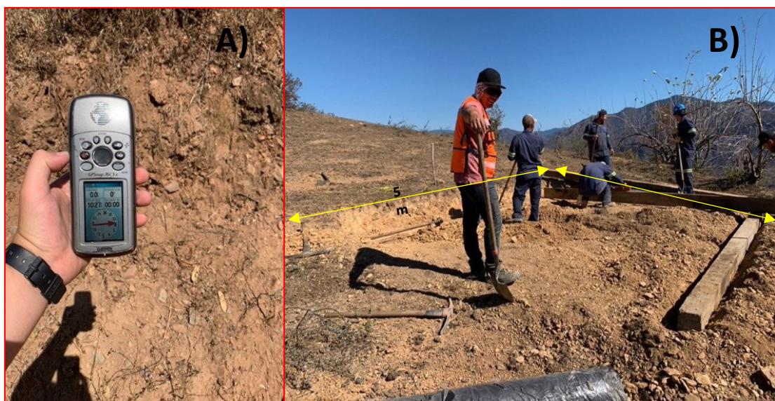
Figura 5. A) GPS GARMIN ubicando nueva plaza de barrenación. B) Acondicionamiento plaza de barrenación con dimensiones de 5 x 5 m, buscando dejarla lo mejor anivelada posibles para proceder con la colocación de polines.
