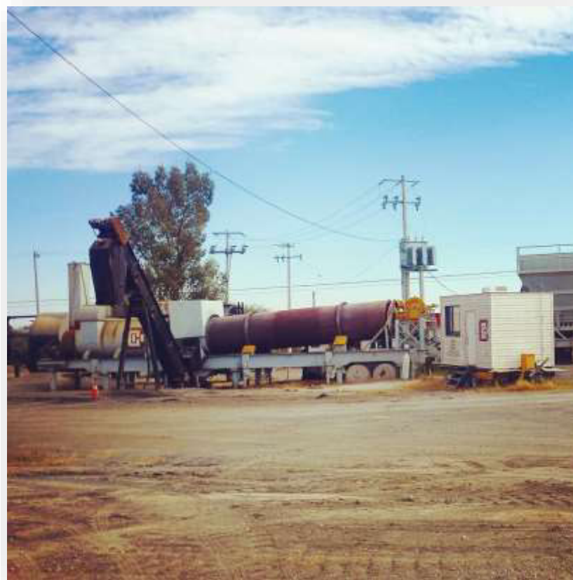
Figura 2.4 Planta de asfalto fija
