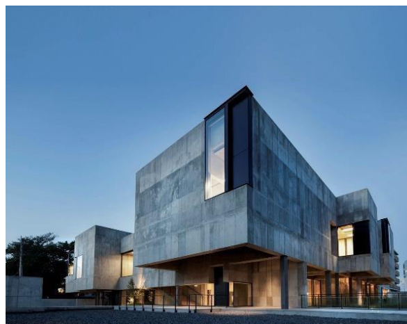
Imagen 31 Fachada Principal Escuela de Tohogakuen. Archdaily 2014.
