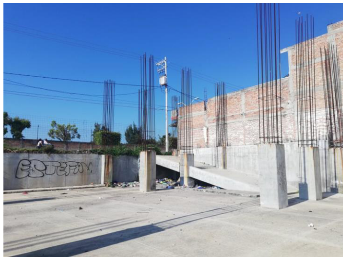
Imagen 60 Vista 12 al Suroeste en el Predio. Propia 2021.
