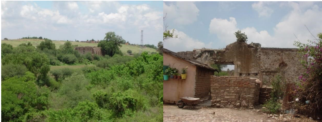
Figura 4. Construcción con contrafuertes ubicada cerca de la comunidad de Los Rodríguez. Figura 5. Vestigios de edificación de adobe y mampostería de piedra en las Galeras Fotos: José Esteban Hernández.
