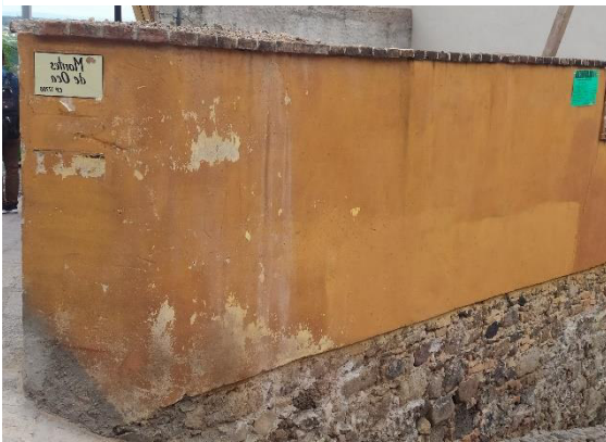
Figura 28 Calle Montes de Oca. Obra recientemente suspendida Fotografía: María José Ramírez
