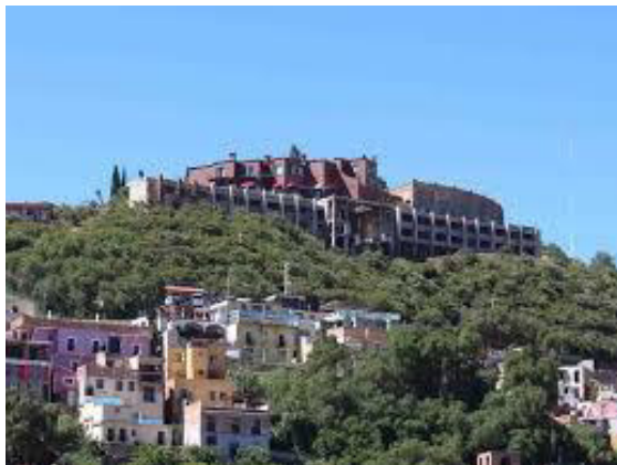
Figura 12. Vista exterior Hotel Misión Casa Colorada Fuente: Internet (sitio web Periódico Correo)
