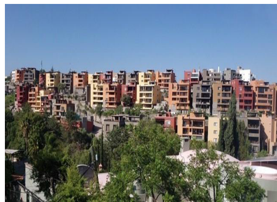
Figura 15. Vista exterior residencial Capilla de Piedra Fuente: Internet (sitio web observatorio ciudadano)
