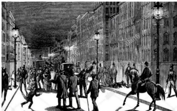
Fig. 2 - Alumbrado público con lámpara de arco de Brush en Nueva York, 1881. Recuperada de: [www.alamy.es](http://www.alamy.es)
