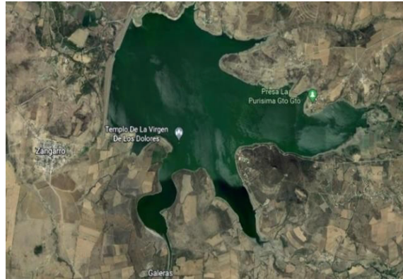
Figura 1. Presa La Purísima.
