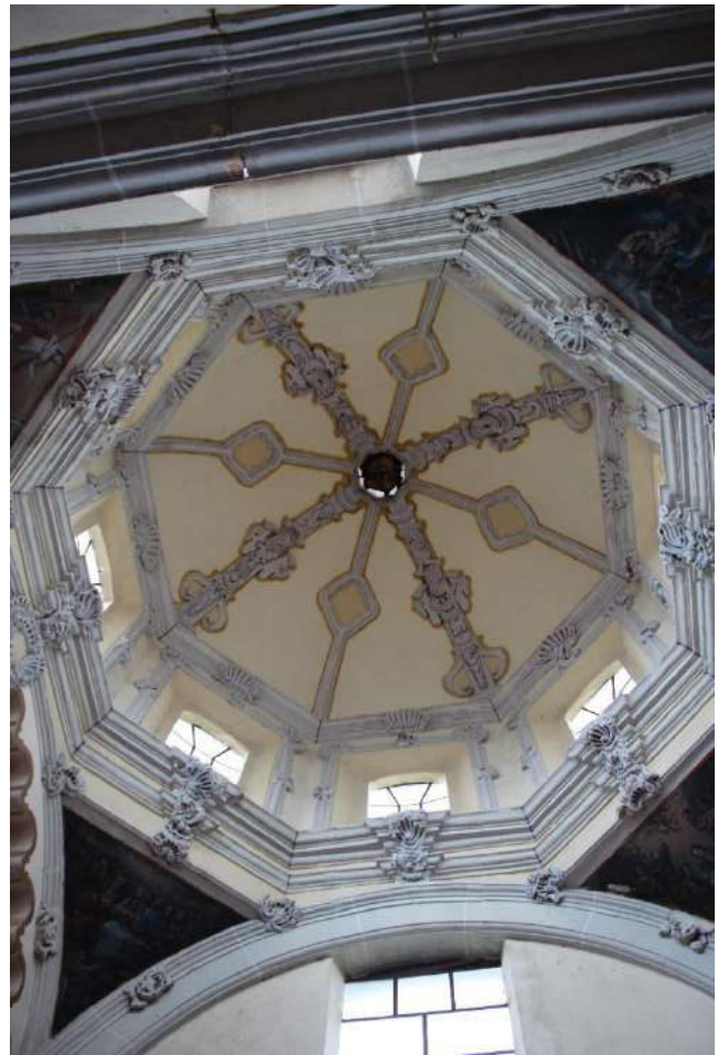
IMAGEN 2. CÚPULA DE LA CAPILLA LATERAL
