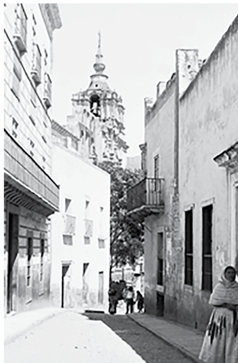
Imagen 2. Colegio del Estado, ubicado en la calle Lascruán de Retana. Fuente: L. Nieto.
