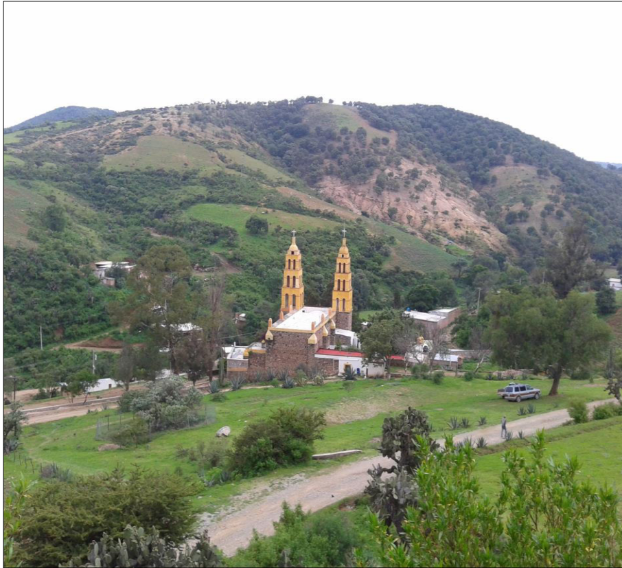
Figura 5. San Antón de las Minas. Fotografía tomada desde el tiro Dolores.
