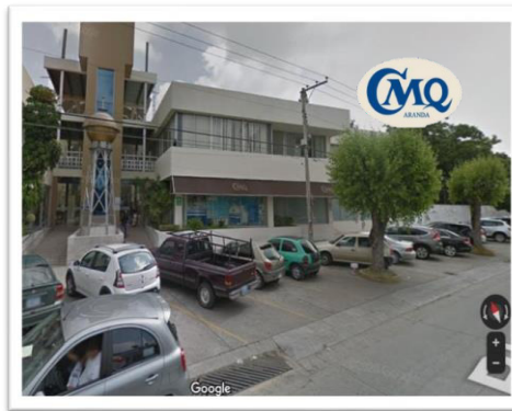
Imagen 3. Hospital CMQ Celaya
