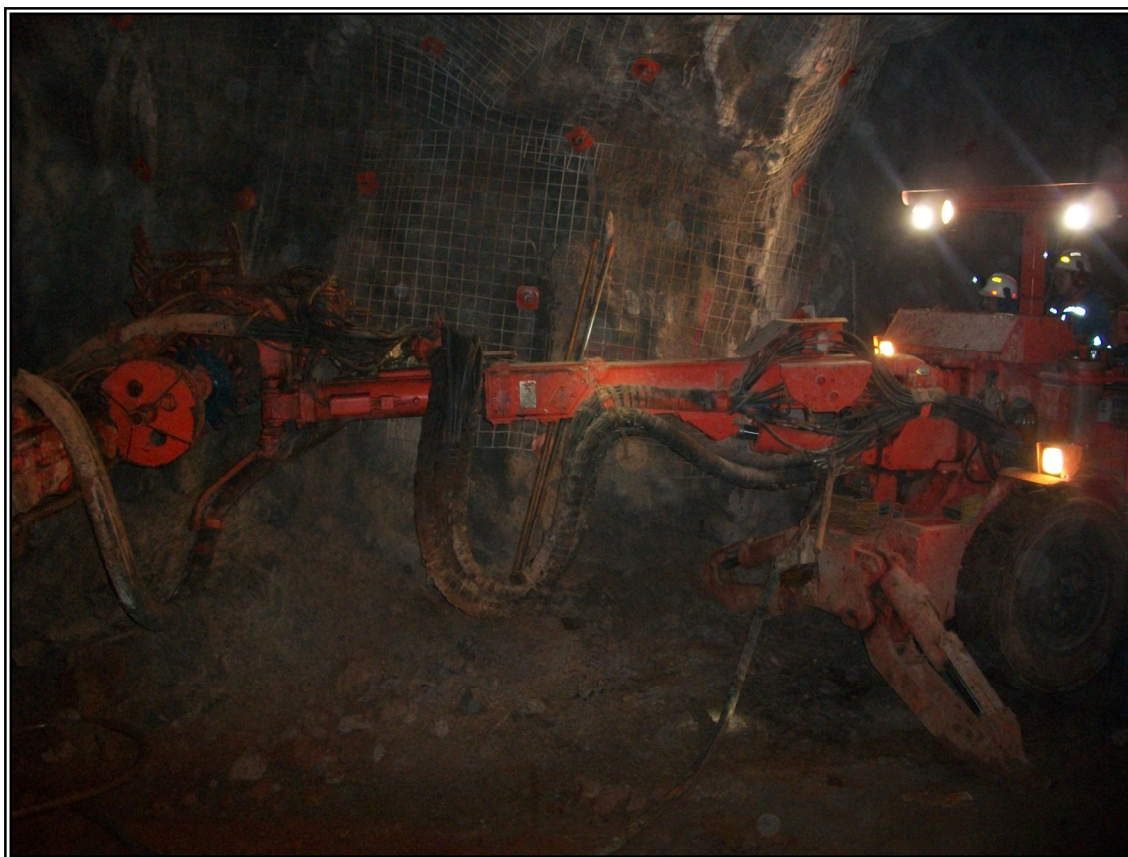
Fotografía 10.- Anclaje de split set con jumbo
