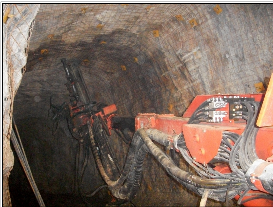
Fotografía 13.- Anclaje de varilla corrugada y malla con jumbo.
