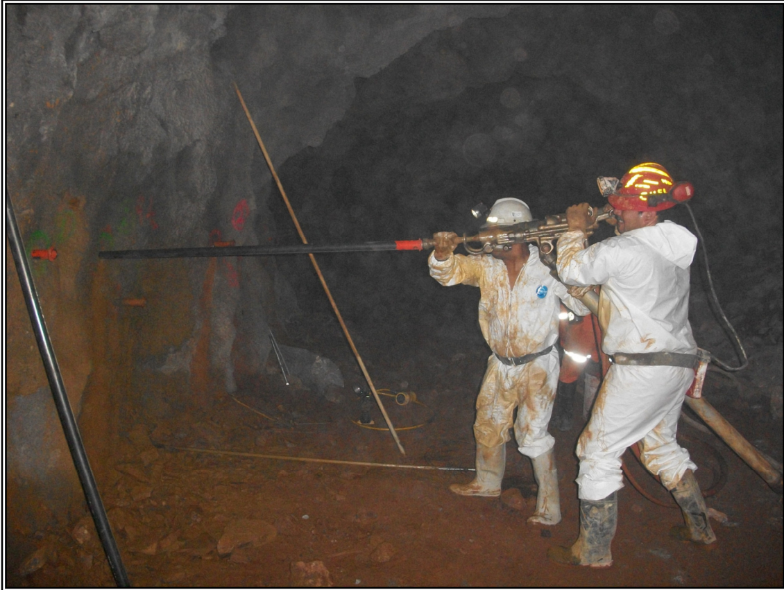
Fotografía 11.- Anclaje de split set con máquina de pierna
