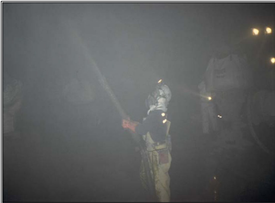
Fotografías 8 y 9.- Lanzado de concreto vía húmeda y vía seca
