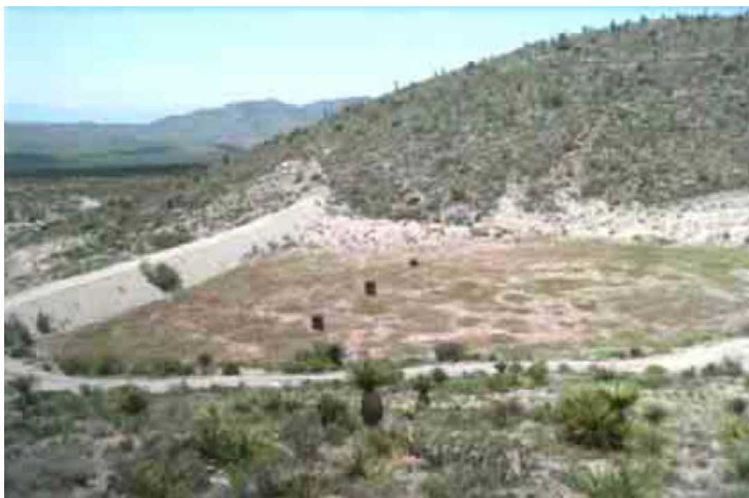
Figura 8.15 a. Vista al NW de la Presa de Jales No. 4 de la Unidad la Encantada, Municipio de Ocampo, Coahuila. (Manifiesto de Impacto Ambiental para Planta de Lixiviación Dinámica y Presa de Jales, Unidad La Encantada).
