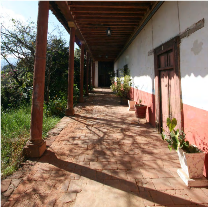
Imagen 106. Piso de barro cocido en galería interior. Fotografía: Marco Gurrola (2020).
