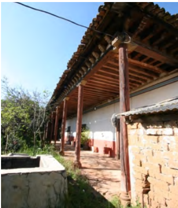
Imagen 133-134. Envigado de galería interior. Envigado de pasillo. Fotografía: Marco Gurrola (2020)
