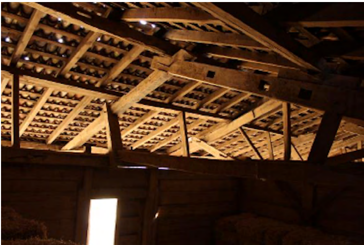
Imagen 68. Entramado de techumbre. Fotografía: Berenice Orozco (2018).
