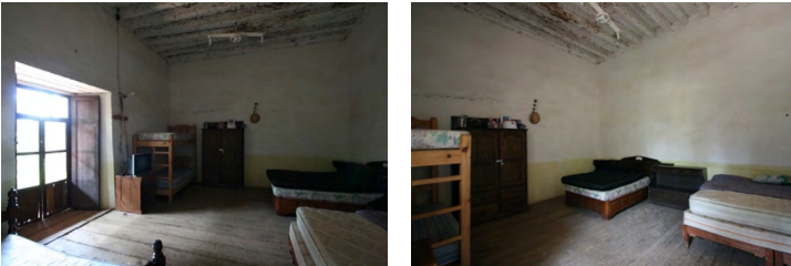
Imagen 109. Piso de tablones de madera en habitaciones. Imagen 110. Piso de tablones de madera en habitaciones. Fotografía: Marco Gurrola (2020).
