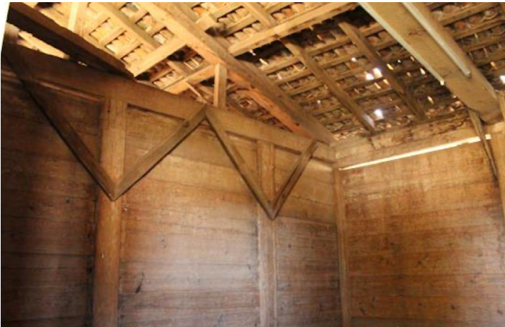
Imagen 53. Diagonales de arriostre. Fotografía: Yazmín Navarro (2018).
