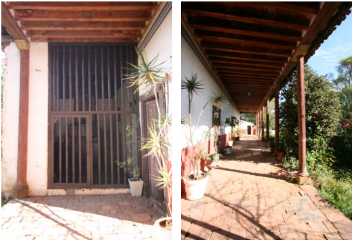
Imagen 121-122. Galería interior. Fotografías: Marco Gurrola (2020).
