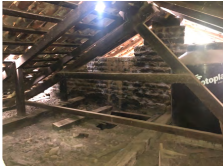
Imagen 149-150. Tijera principal con puntales y secundaria con arrastres. Par-nudillo en tijera auxiliar. Fotografías: Liliana Frausto (2020).
