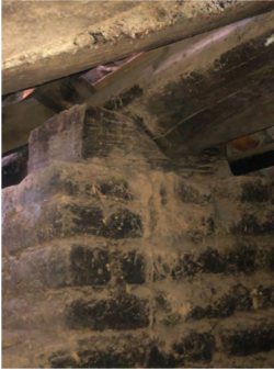
Imagen 147-148. Arrastre con rebaje para evitar rodamientos. Fotografías: Liliana Frausto (2020). Tijeras principales con puntales.
