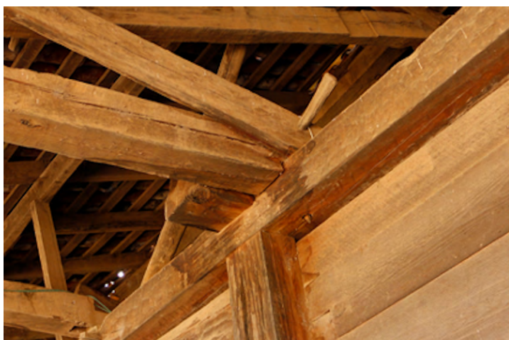
Imagen 59. Unión de columna, viga principal, cordones y tirantes. Fotografía: Luis Arellano (2018).
