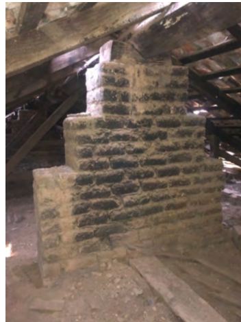
Imagen 145-146. Correas y tejas. Nudillo en tijera auxiliar. Murete de apoyo. Fotografías: Liliana Frausto (2020).
