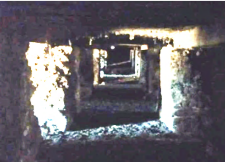
Imagen 41. Poyos de cimentación. Fotografía: Gerardo Garnica (2018).
