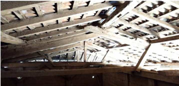
Imagen 35. Interior de cubierta: Se observa casi la totalidad de elementos que conforman la estructura de cubierta: los tirantes, los pares y la teja. Fotografía: René Navarrete (2018).
