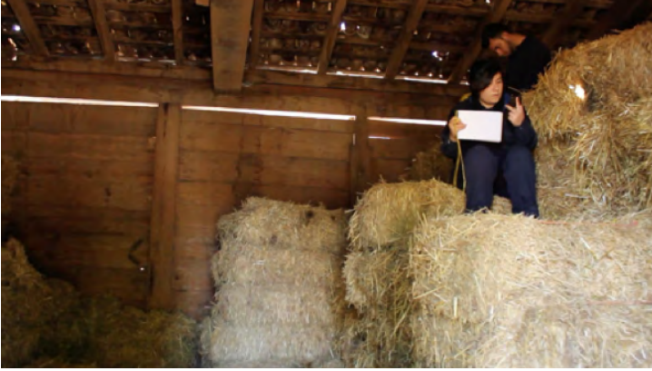
Imagen 30. Cuarto 2: Función de almacén de pacas de paja para alimento, se observa en la estructura de madera en diagonal y ménsulas que fueron colocadas en una época posterior.
