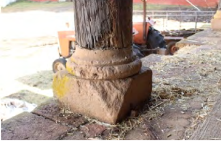
Imagen 27. Base de las columnas. Fotografía: Berenice Orozco (2018).
