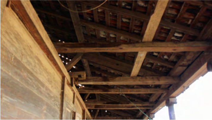
Imagen 36. Interior de cubierta: Tomada desde la galería apreciando los cordones que llegan a la viga de columnas. Fotografía: Berenice Orozco (2018).
