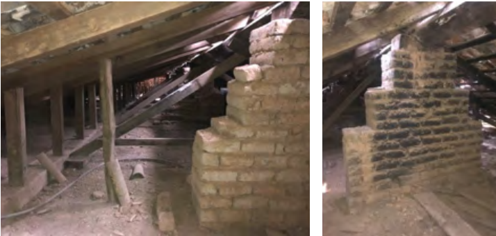
Imagen 140-141. Tapanco. Murete de adobe sobre muro inferior para soporte de hilera.
