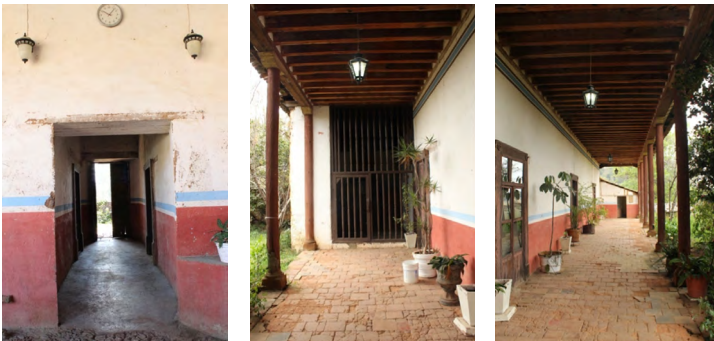
Imagen 85-86-87. Pasillo de acceso a cuartos y galería interior.
