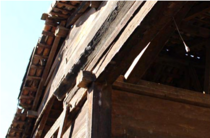
Imagen 52. Ensamblés entre columna y solera superior, eje A. Fotografía: Yazmín Navarro (2018).
