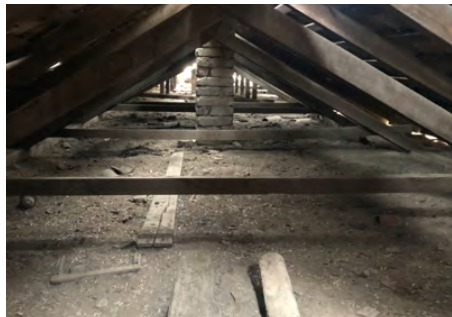
Imagen 151-152. Parhilera en tijera auxiliar. Parhilera en tijera auxiliar. Fotografía: Liliana Frausto (2020).
