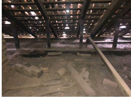
Imagen 147-148. Arrastre con rebaje para evitar rodamientos. Fotografías: Liliana Frausto (2020). Tijeras principales con puntales.
