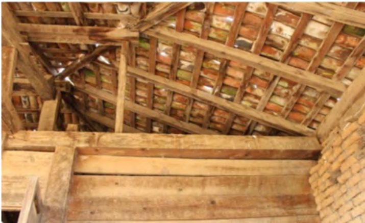
Imagen 37. Interior de cubierta. Tomada desde la galería donde se ve la inclinación de la tercera agua que da hacia la calle, el muro de adobe de la galería y el tabique de madera del cuarto 5. Fotografía: Berenice Orozco (2018).
