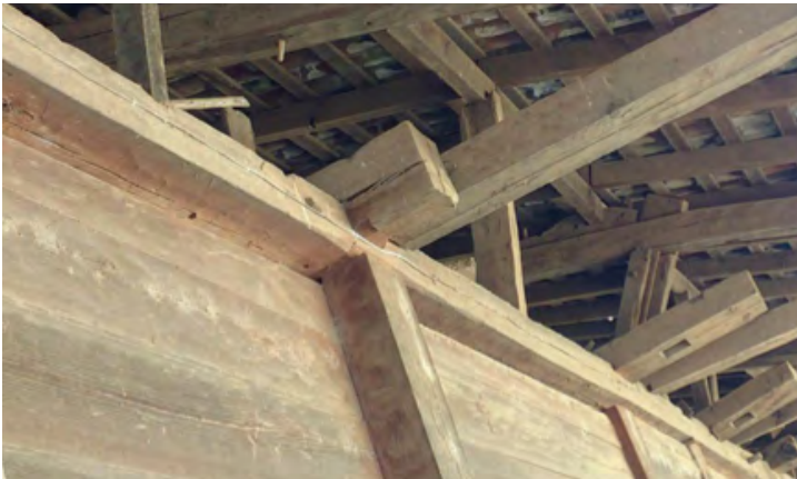
Imagen 57. Ensamble de columna a media madera.
