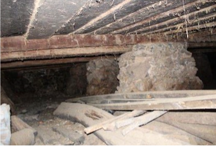
Imagen 43. Poyos de cimentación. Fotografía: Berenice Orozco (2018).
