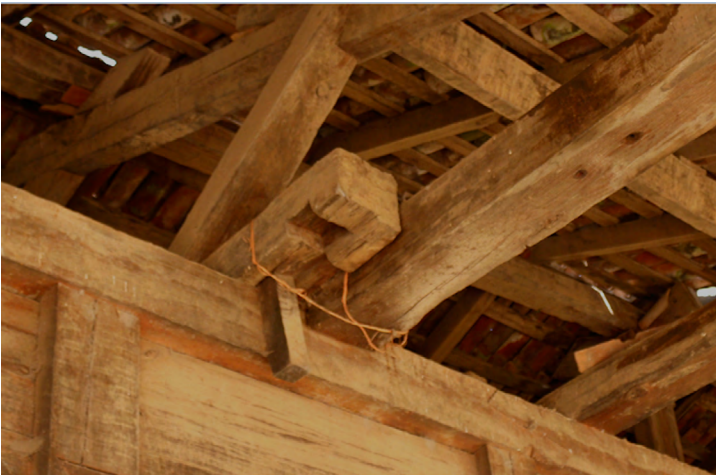
Imagen 64. Tirante con clavija. Fotografía: Luis Arellano (2018).
