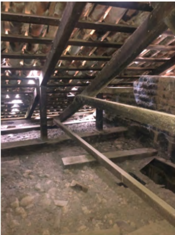
Imagen 145-146. Correas y tejas. Nudillo en tijera auxiliar. Murete de apoyo. Fotografías: Liliana Frausto (2020).
