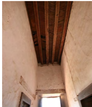
Imagen 133-134. Envigado de galería interior. Envigado de pasillo. Fotografía: Marco Gurrola (2020)
