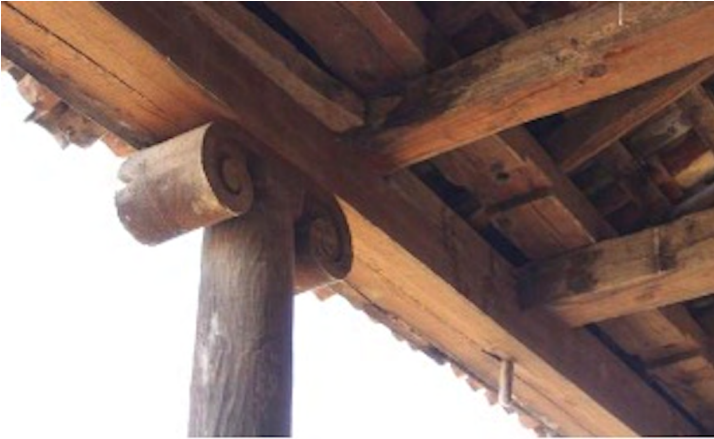
Imagen 47. Zapata de galería tallada con características jónicas. Fotografía: Berenice Orozco (2018).
