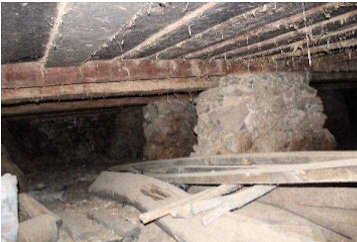
Imagen 43. Poyos de cimentación. Fotografía: Berenice Orozco (2018).
