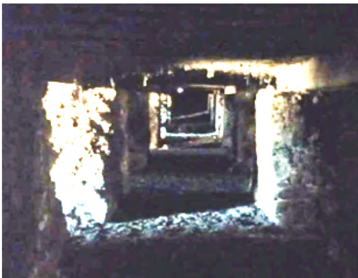
Imagen 17. Interior-cimentación: Se observan los poyos que dan firmeza a la estructura de madera.
