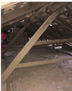
Imagen 151-152. Parhilera en tijera auxiliar. Parhilera en tijera auxiliar. Fotografía: Liliana Frausto (2020).
