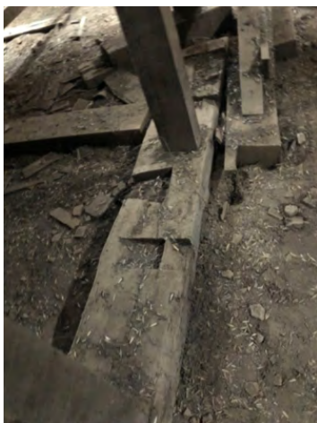
Imagen 153-154. Apoyo de puntales en arrastres. Poyo de tijera auxiliar en arrastres.
