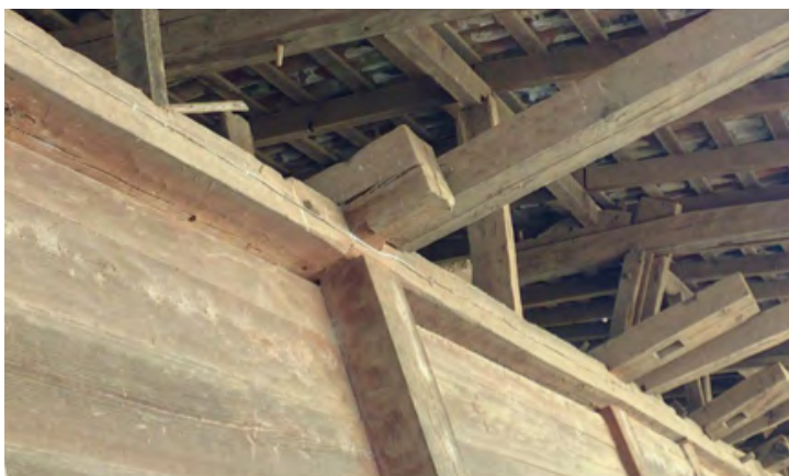
Imagen 57. Ensamble de columna a media madera.
