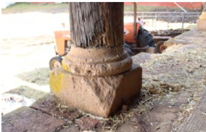
Imagen 27. Base de las columnas. Fotografía: Berenice Orozco (2018).
