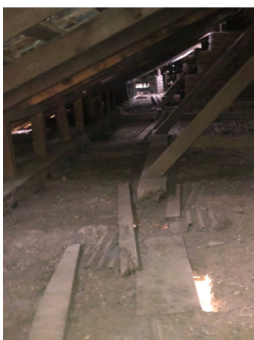
Imagen 149-150. Tijera principal con puntales y secundaria con arrastres. Par-nudillo en tijera auxiliar. Fotografías: Liliana Frausto (2020).
