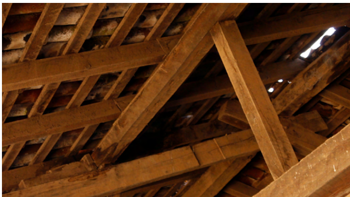
Imagen 69. Punta y correa auxiliar. Fotografía: Luis Arellano (2018).
