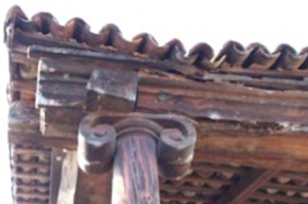
Imagen 28. Detalles de las columnas: Capitel tallado en madera de orden jónico con volutas, decorando la fachada principal de la troje. Fotografía: Berenice Orozco (2018).
