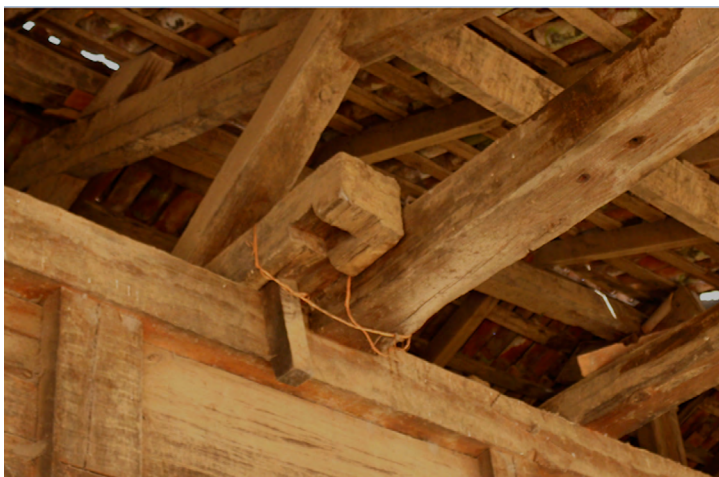
Imagen 64. Tirante con clavija. Fotografía: Luis Arellano (2018).
