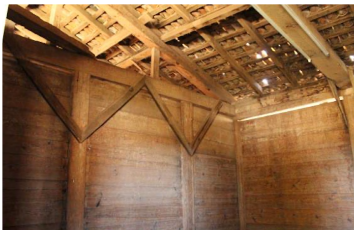
Imagen 53. Diagonales de arriostre. Fotografía: Yazmín Navarro (2018).
