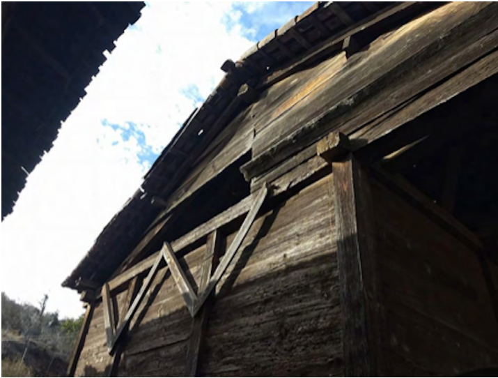
Imagen 18. Fachada sur: Fotografía donde se observan detalles de refuerzos diagonales sobre los pilares, tipo cartabón, y el grado de deterioro de la fachada.
