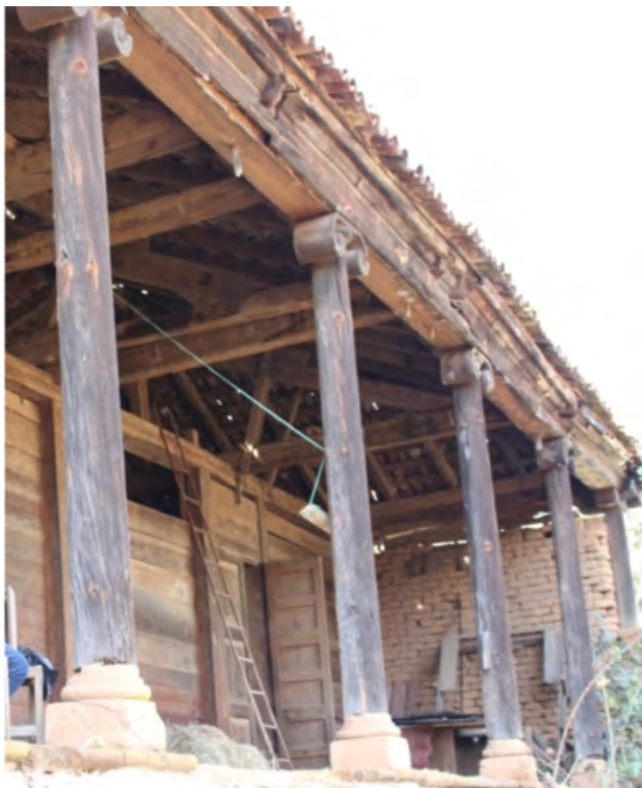
Imagen 70. Columnas en galería. Fotografía: Berenice Orozco (2018).
