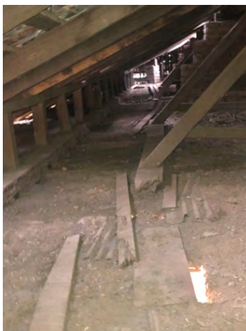
Imagen 153-154. Apoyo de puntales en arrastres. Poyo de tijera auxiliar en arrastres.
