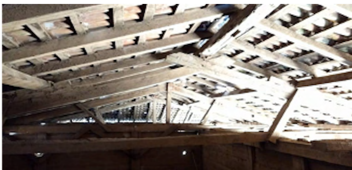
Imagen 35. Interior de cubierta: Se observa casi la totalidad de elementos que conforman la estructura de cubierta: los tirantes, los pares y la teja. Fotografía: René Navarrete (2018).
