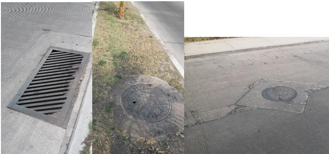
FIGURA 58 - Alcantarillado pluvial y drenaje FUENTE: Propia
