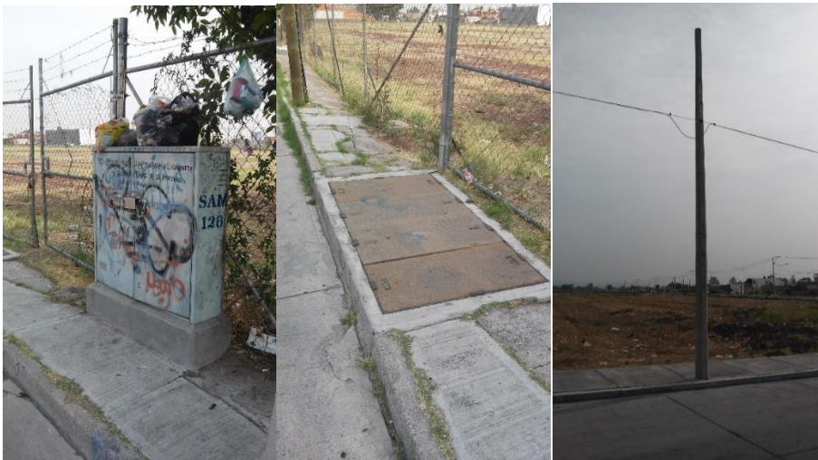
FIGURA 57 - Registros telefónicos y red de electrificación FUENTE: Propia
