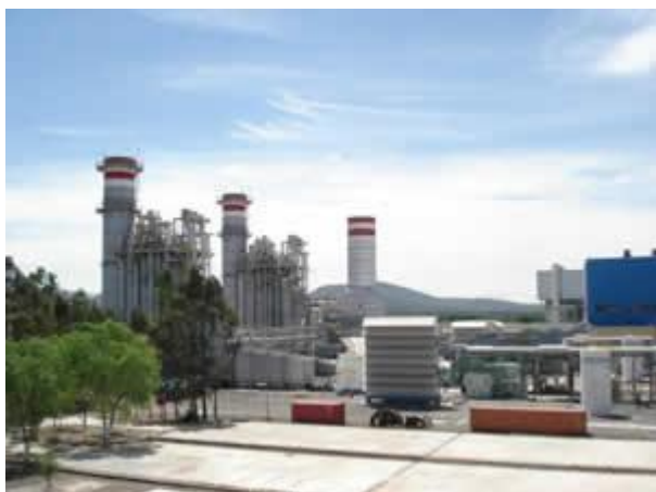
FIGURA 23 - Contaminación por la termoeléctrica
