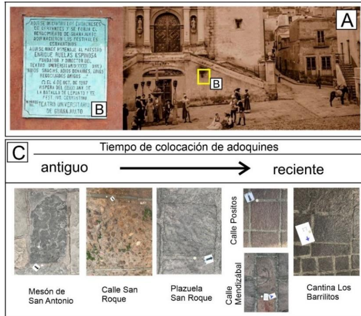
Figura 4. Las transformaciones en los materiales empleados en los pisos de calles de la ciudad de Guanajuato. A, Plazuela de San Roque en donde se observa el cambio de empedrado a un piso de adoquines. B, placa conmemorativa de entremeses que se realizan en la plazuela con la ubicación actual. C. Línea de tiempo de la construcción de algunas calles de la ciudad de Guanajuato.
