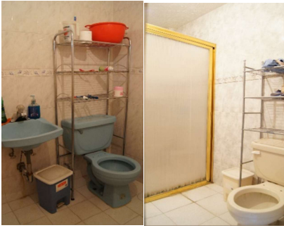
Fotogr. 09. "Acabados en sanitarios".
