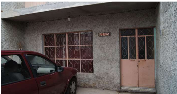
Fotogr. 03. "Fachada planta baja".
