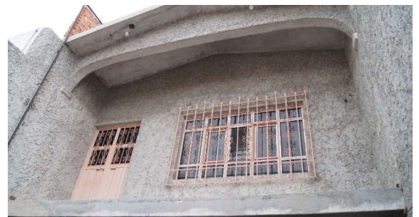
Fotogr. 04. "Fachada planta alta".
