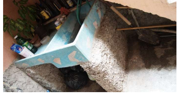
Fotogr. 14. "Lavadero en patio".
