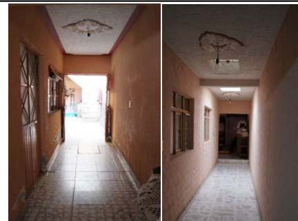
Fotogr. 06. "Acabados en pasillos".
