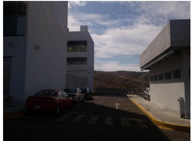
Ilustración 18 Acceso vehicular por el Edificio de Artes
