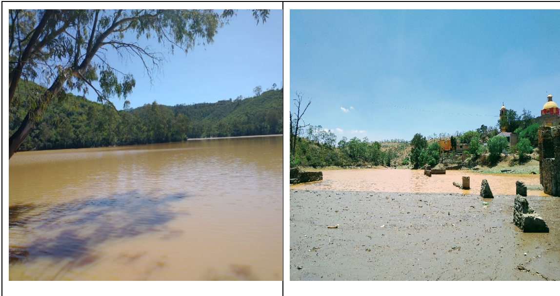
Figura 6. A) Presa de la Esperanza y B) Presa de la Soledad.
